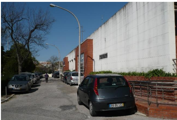
Figura 122 - Limite visual este do jardim do Quebedo, (Fonte: autora do trabalho)
