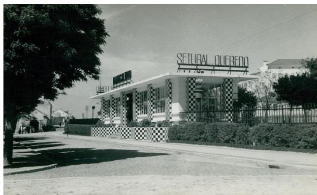
Figura 112 - Estação do Quebedo, 1970 (Fonte: www.delcampe.net )
