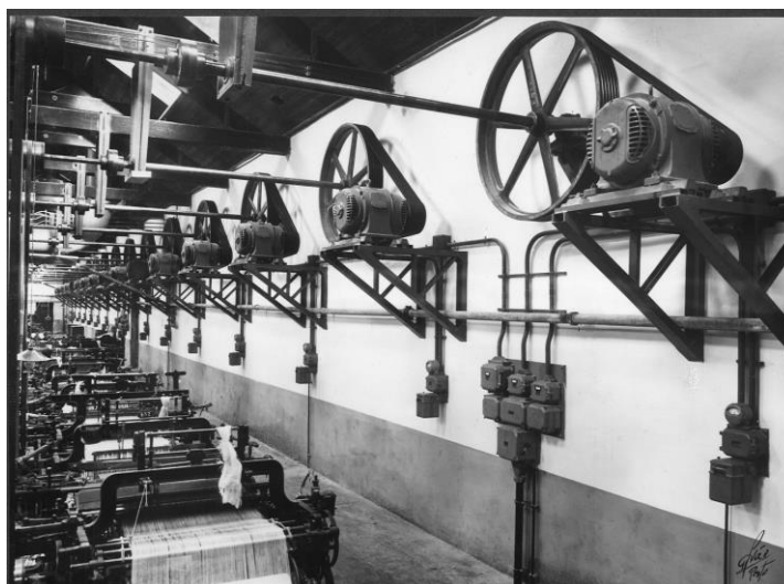
Fig. 56 – Motores elétricos ASEA instalados numa unidade têxtil. Estes estão instalados na parede, ligados a um eixo que transmite energia ao tear. Primeira fase da instalação dos motores elétricos.
