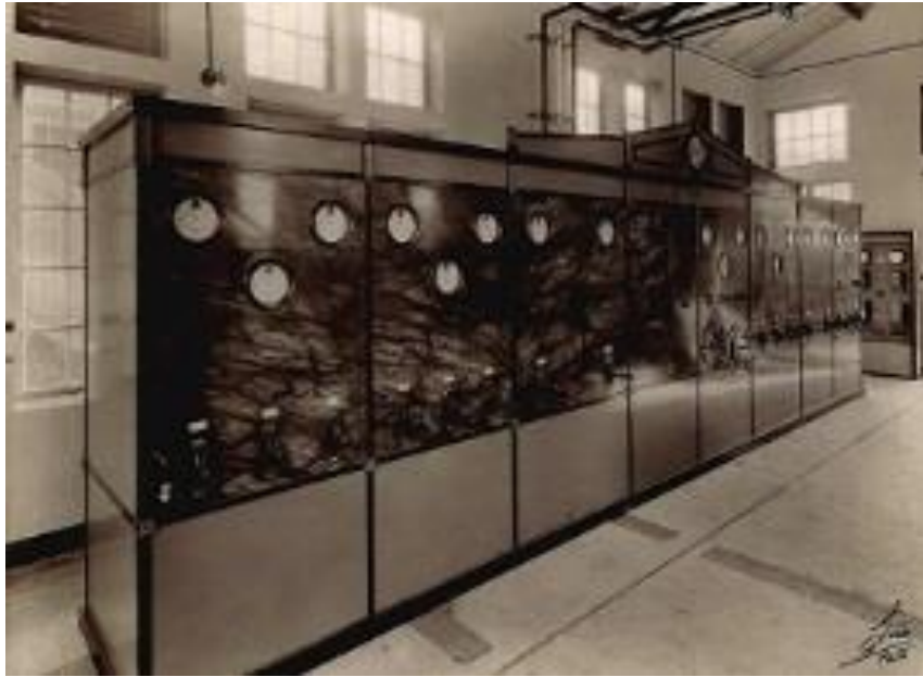
Fig. 82 - Projecto da empresa “O Primeiro de Janeiro, 1935” - Painéis de comandos.
