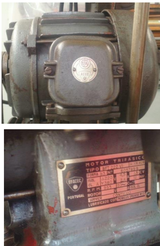
Fig. 52 - Motor EFA ACEC do Tear da Fábrica de Sedas Globo e placa do motor com o registo da reparação realizada pela própria EFACEC.
