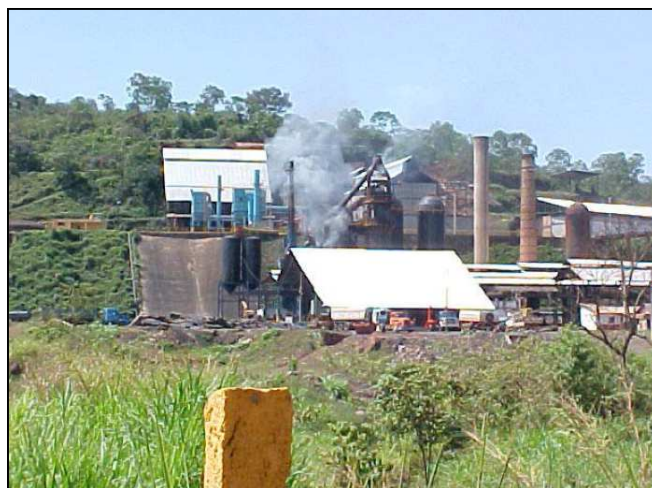
Figura 2.19 – Siderurgia localizada nas margens do rio Maranhão (IGAM, 2005).
