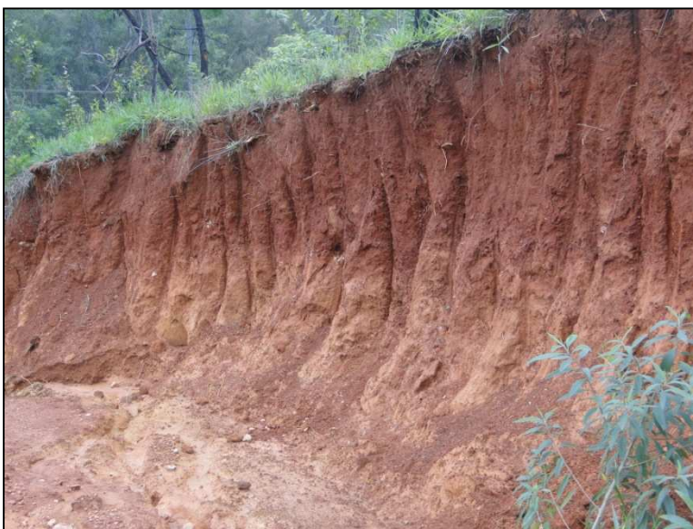
Figura 6.1 – Efeitos da erosão hídrica em Congonhas (Rio Preto - MG) (Grupo 8 dos locais de amostragem analisados) (Foto: Fernandes, 2011).
