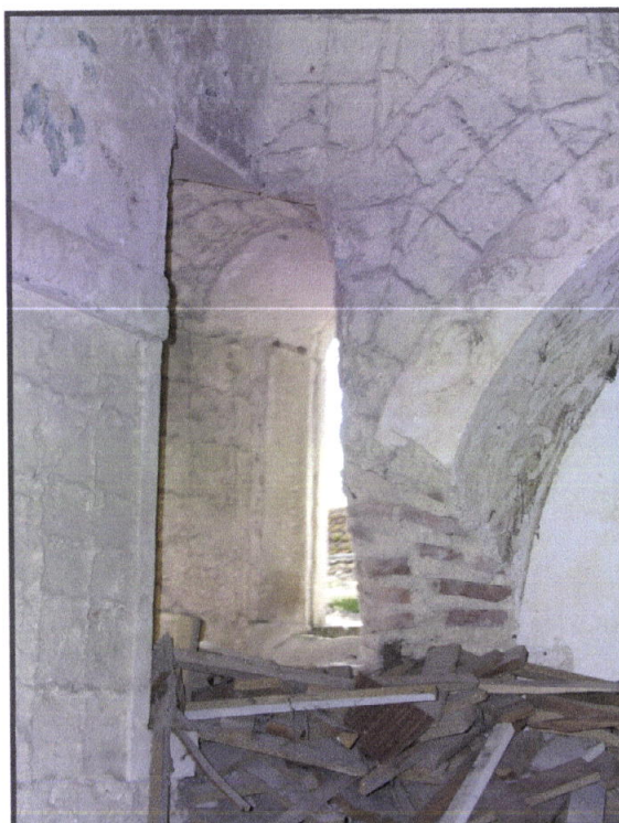
Foto 29 – Capela adjacente ao antigo claustro.
