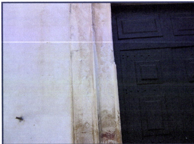
Foto 72 – Patologias do calcário oolítico da ombreira esquerda do portal: escamação, lascagem e esfoliação.
