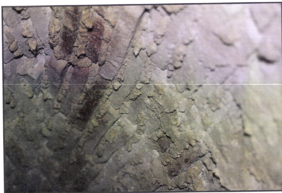
Foto 38 – Abóbada com tijolo ao cutelo.
