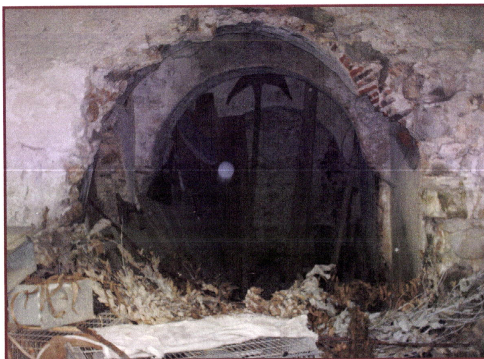
Foto 94 – Dependência abobadada do piso térreo do dormitório.
