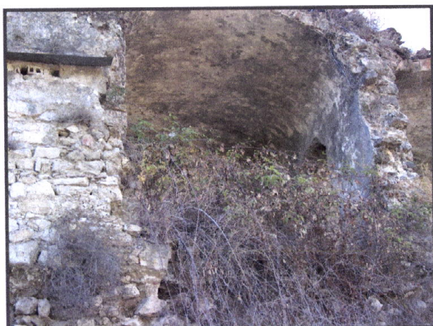
Foto 88 – Pormenor da colonização biológica no alçado nascente do dormitório.
