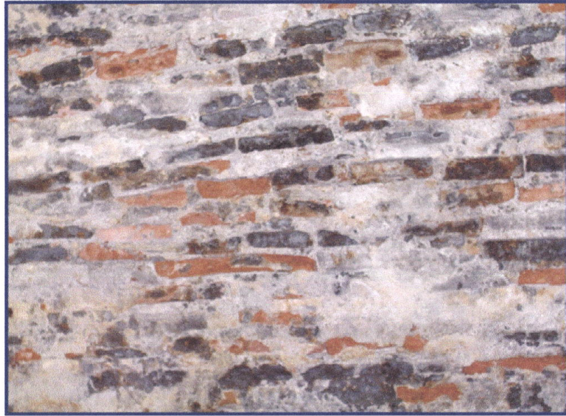
Foto 43 – Abóbada do piso térreo do dormitório.
