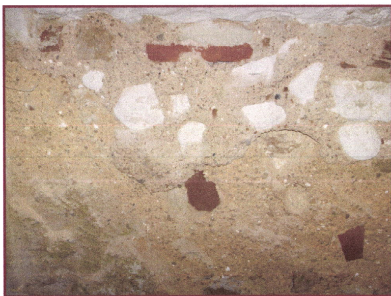
Foto 40 – Alvenaria de pedra irregular e tijolo com ligante de argamassa de cal e areia. Parede interior da casa da grade.
