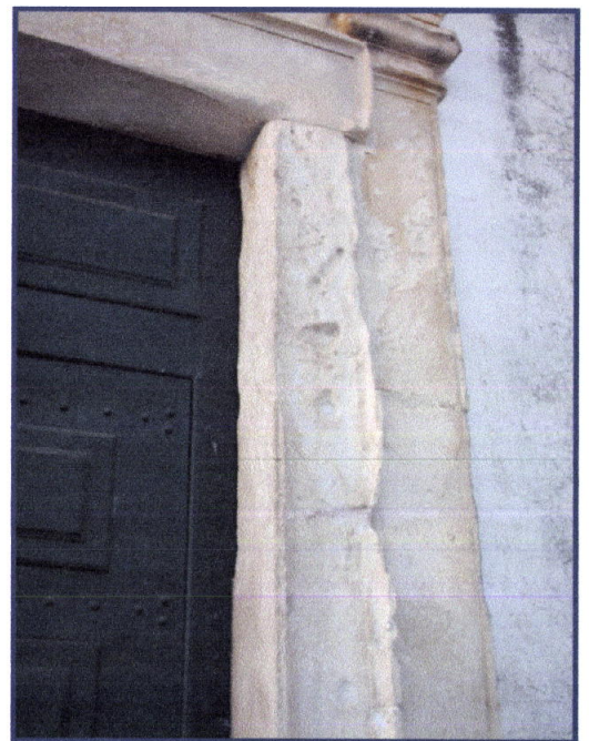
Fotos 76 e 77 – Patologias do calcário oolítico da ombreira direita do portal: alveolização e apagamento das formas.
