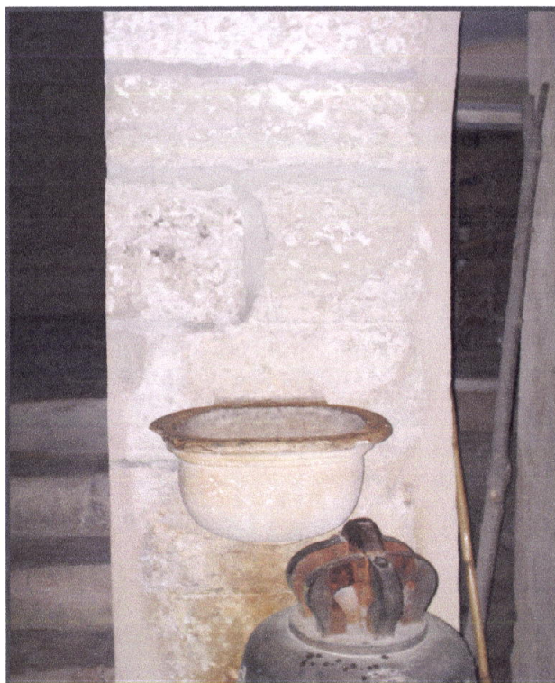
Foto 46 – Estrutura de pedra aparelhada visível na portaria da igreja.
