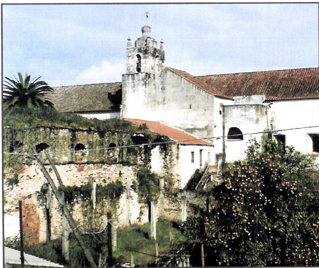
Foto 26 – Alçado nascente do dormitório.
