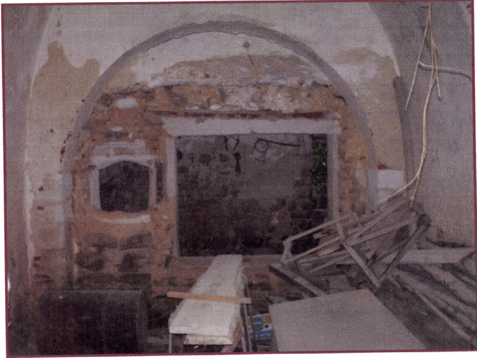
Foto 30 – Casa da grade situada no piso térreo do dormitório.
