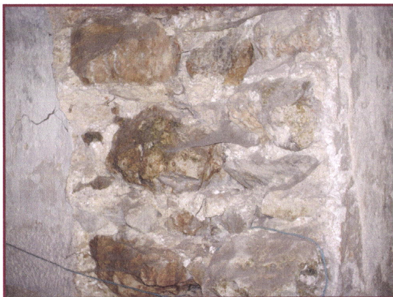
Foto 39 – Alvenaria de pedra irregular com ligante de argamassa de cal e areia. Parede resistente do alçado poente do dormitório.
