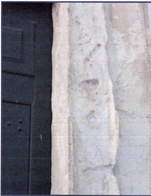
Fotos 76 e 77 – Patologias do calcário oolítico da ombreira direita do portal: alveolização e apagamento das formas.
