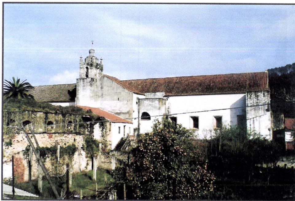
Foto 85 – Alçado nascente do dormitório.
