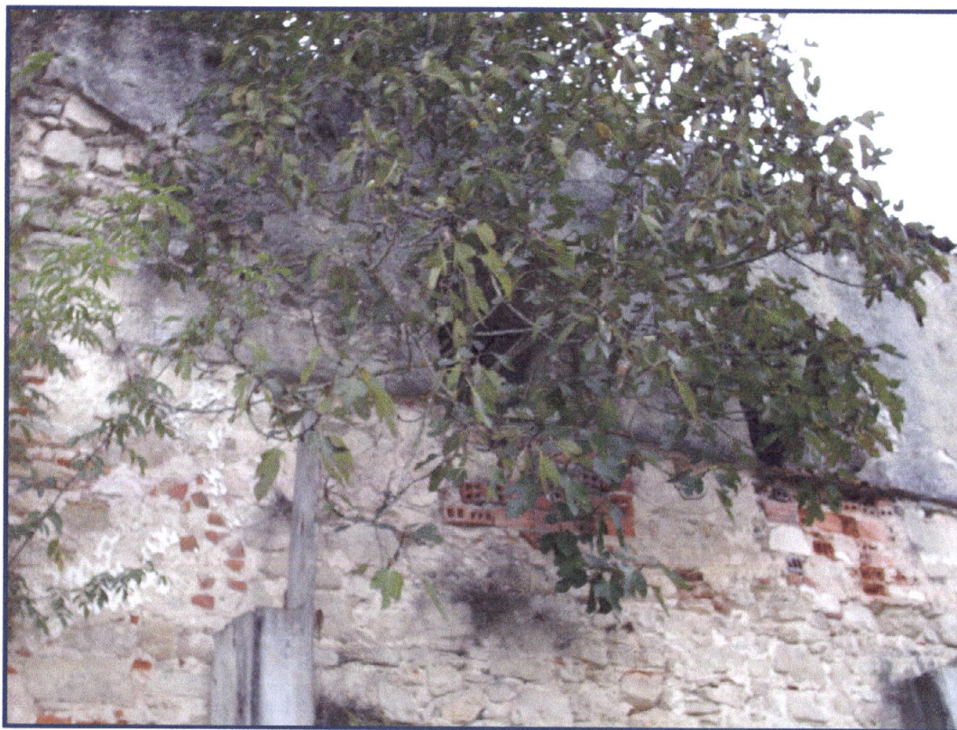
Foto 99 – Vegetação superior no alçado nascente do dormitório.
