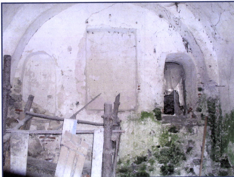
Foto 93 – Dependência abobadada do piso térreo do dormitório.
