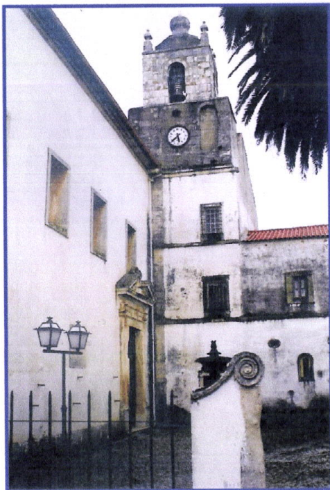
Foto 23 – Edifício do antigo dormitório situado a sul e perpendicular à igreja.
