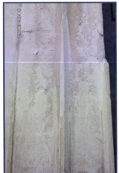
Foto 73 – Pormenor: escamação, lascagem e esfoliação.
