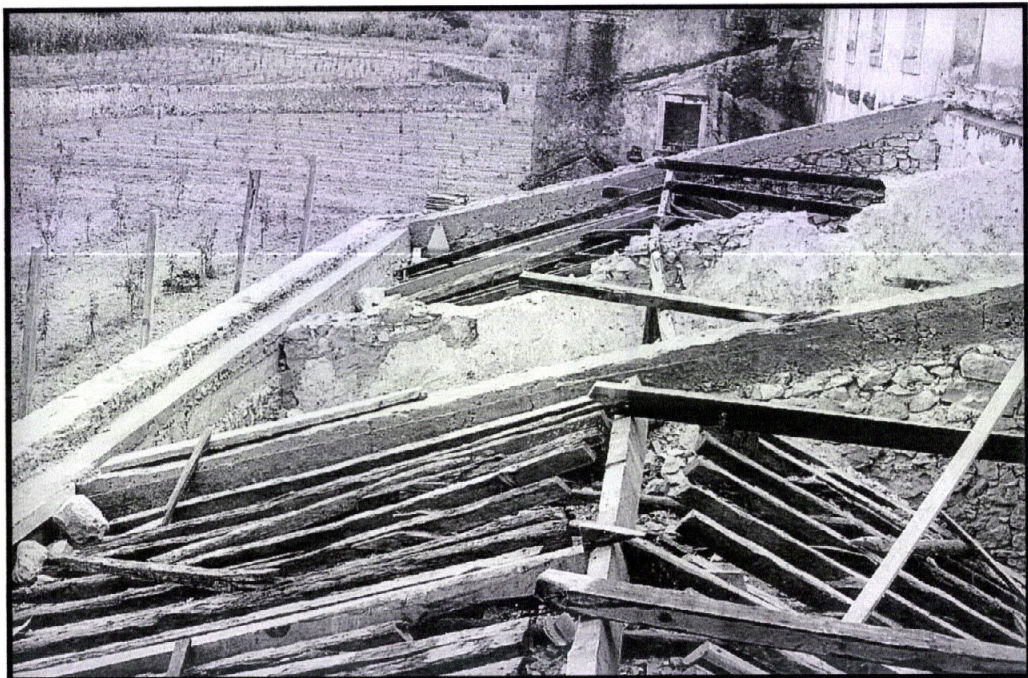
Foto 56 – Consolidação estrutural com cintagem em betão armado do telhado da sacristia (década de 1970). DGEMN
