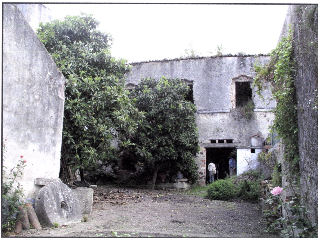
Foto 90 – Alçado poente do dormitório: vão de acesso à casa da grade.
