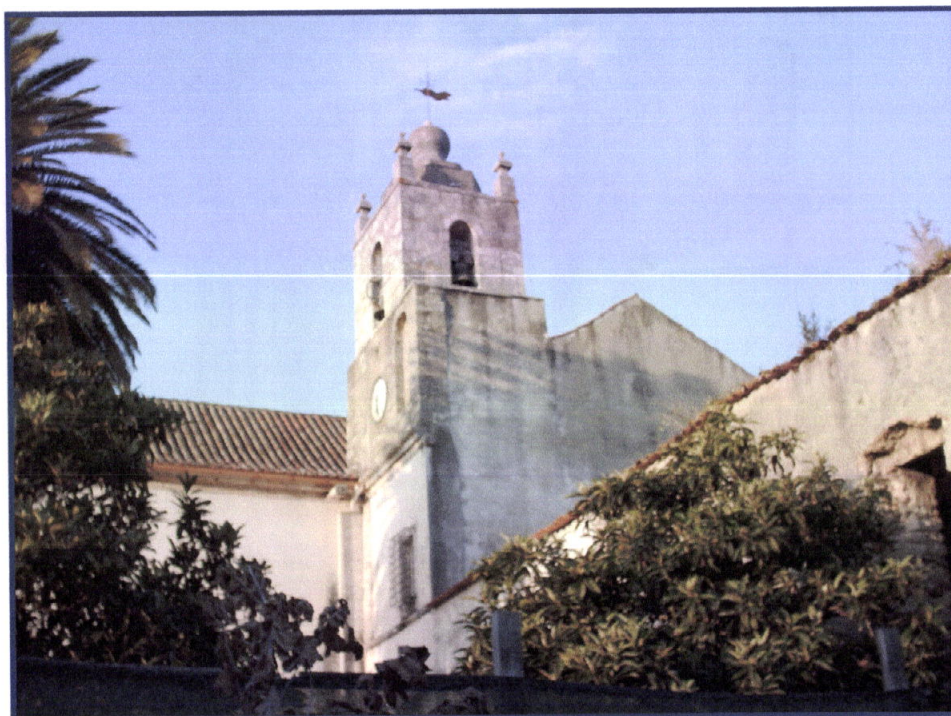
Foto 25 – Vista parcial do edifício do antigo dormitório devido às estruturas que lhe foram adossadas.
