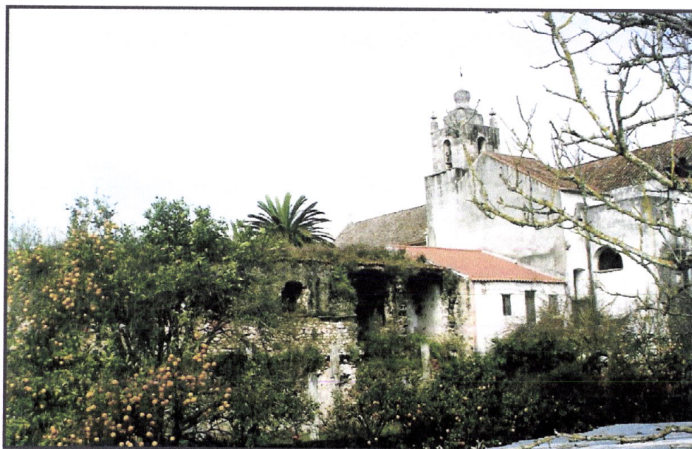
Foto 86 – Casa de habitação inserida no antigo dormitório.
