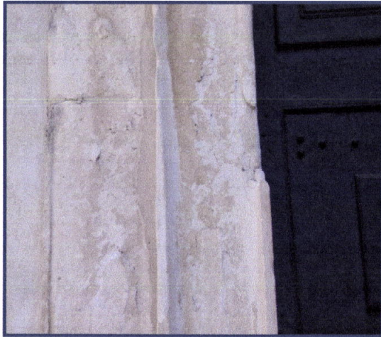
Fotos 74 e 75 – Pormenor: escamação, lascagem e esfoliação.
