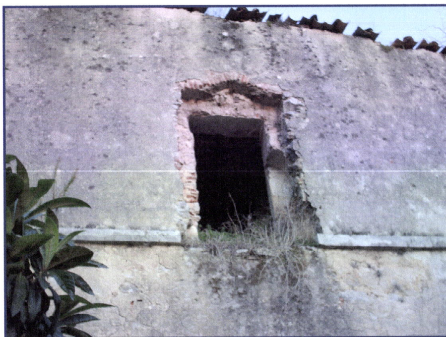
Foto 42 – Vão de janela com arco de descarga construído em tijolo maciço. Alçado poente do dormitório.
