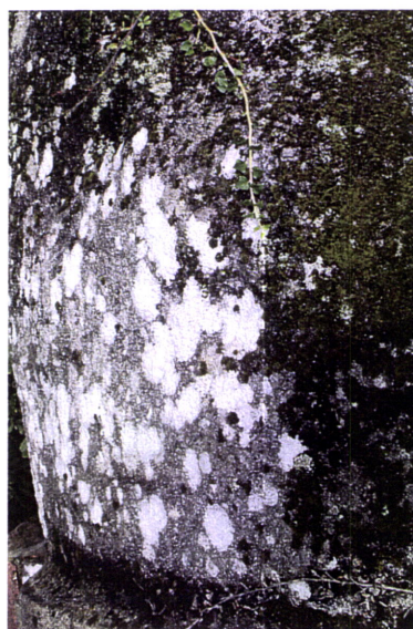
Figuras64 e 65 – Ataque do granito por colonização biológica
