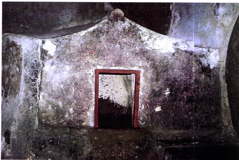
Figura 55 – Cisterna da casa das águas
