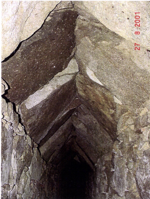
Figuras 52 e 53 – Mina do alto da Memória – pormenor do tecto e da caixa de decantação
