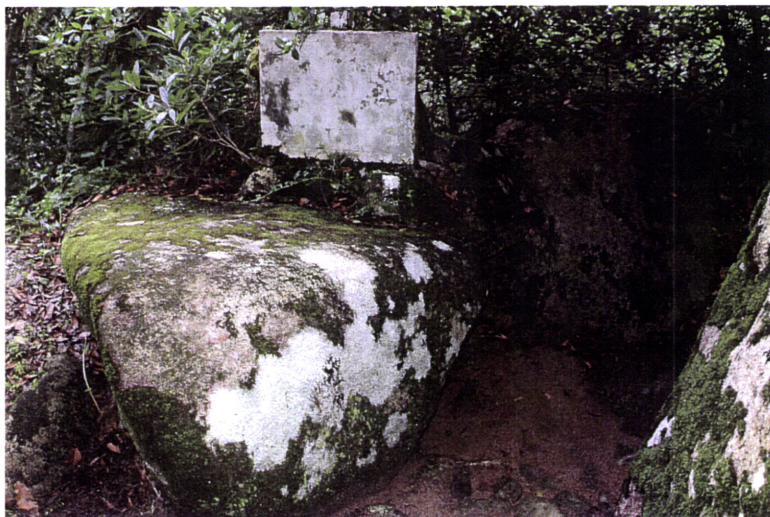
Figura 43 – Presença de líquenes nos blocos de granito junto à gruta de Frei Honório
