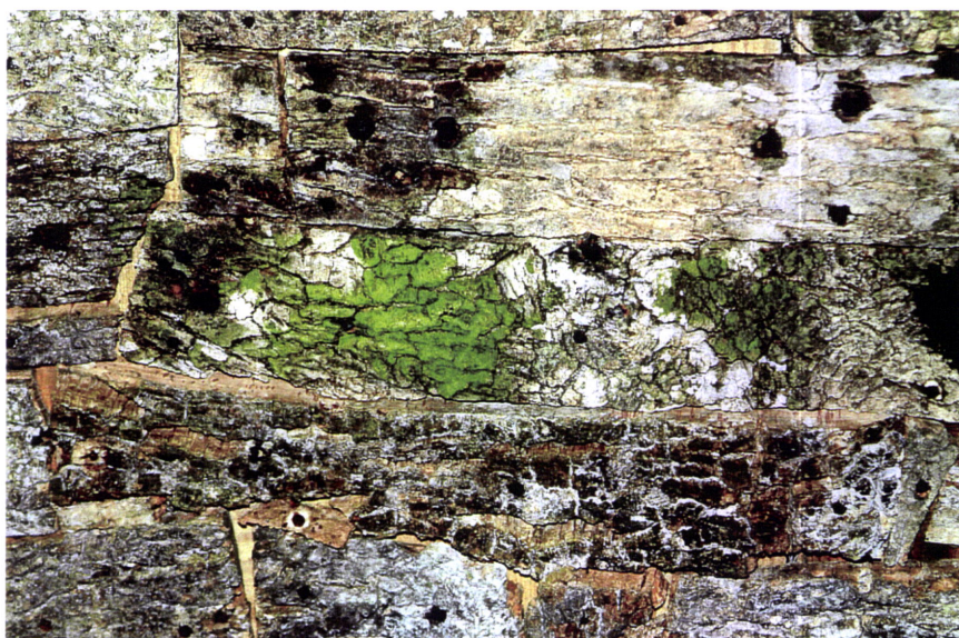
Figura 69 – Aplicação de cortiça como revestimento apresentando ataque por agentes biológicos
