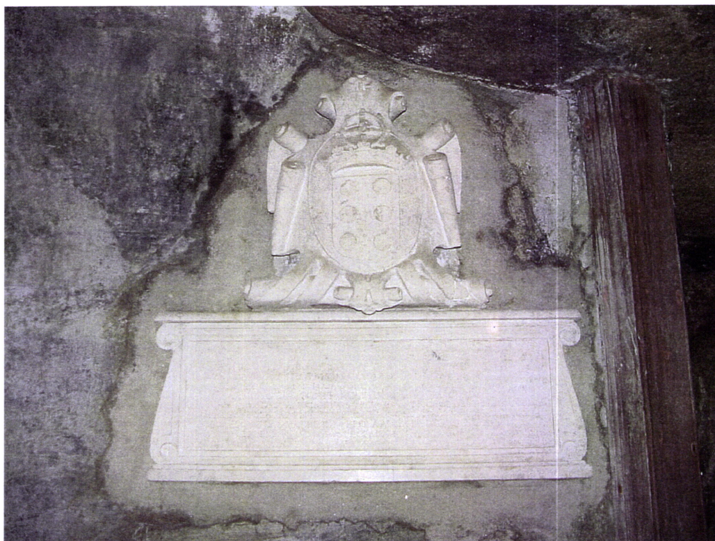
Figura 39 – Brasão dos Castro, em mármore
