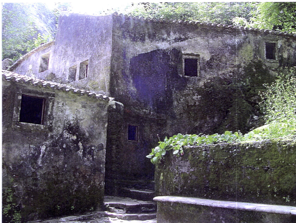
Figura 31 – Vista parcial do edifício a partir do claustro
