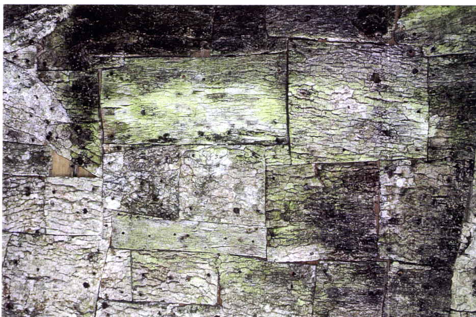
Figura 35 – Aplicação de cortiça no interior do convento
