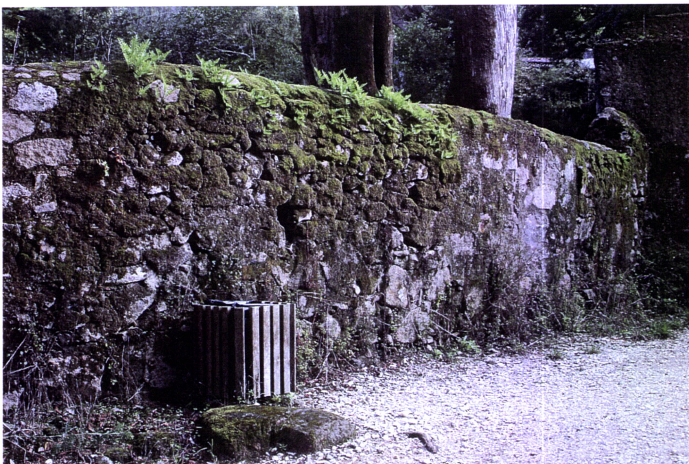
Figura 68 – Muro de suporte na zona das hortas
