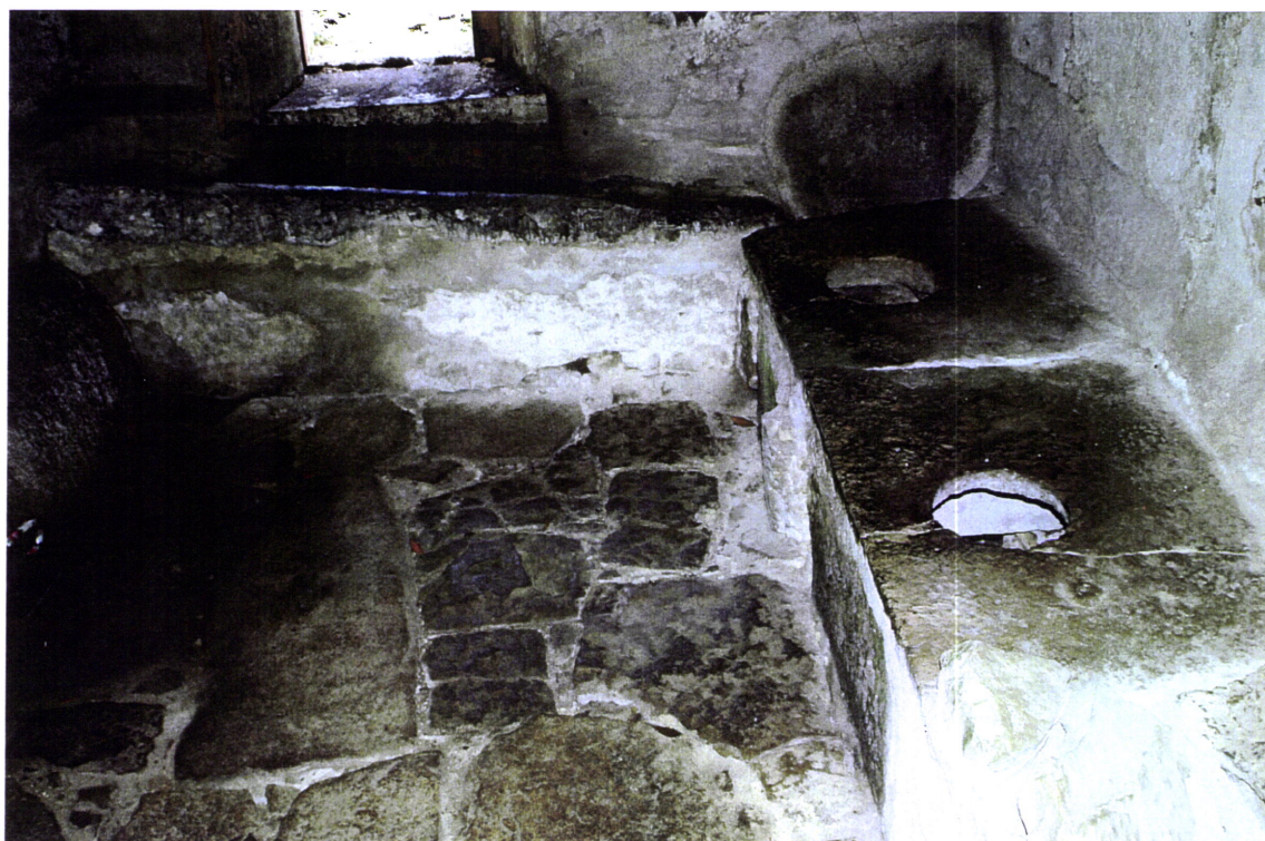
Figura 57 – Casa das águas – pormenor das latrinas e caleira
