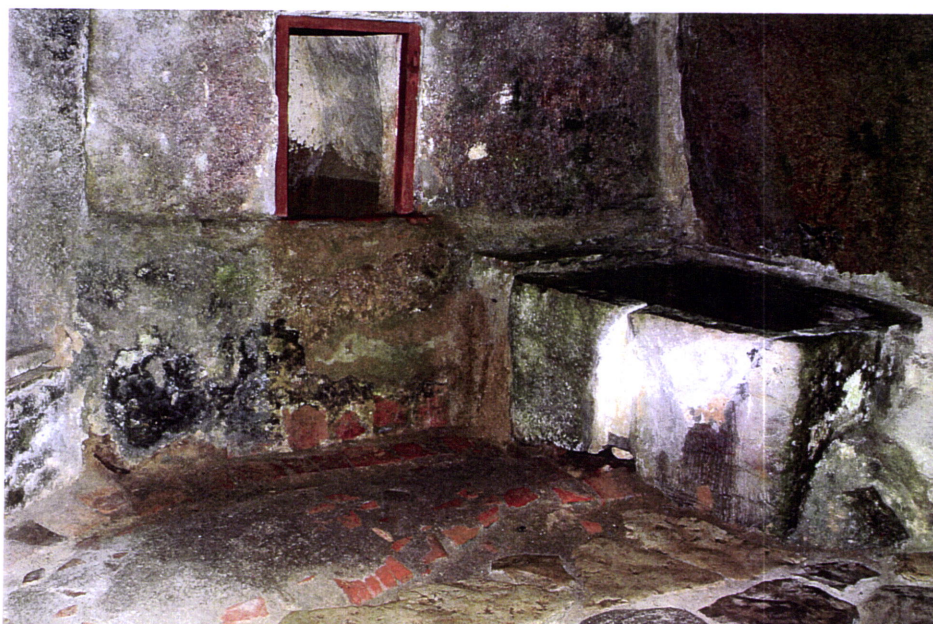
Figura 56 – Cisterna e caixa de decantação na casa das águas
