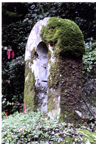
Figuras64 e 65 – Ataque do granito por colonização biológica
