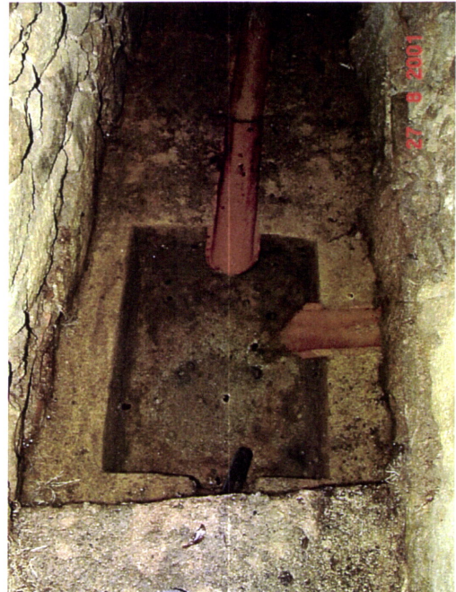
Figuras 52 e 53 – Mina do alto da Memória – pormenor do tecto e da caixa de decantação
