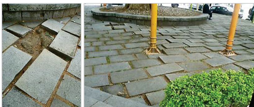
Figura 62 - Fotografias da instabilidade do pavimento envolvente ao Plátano
