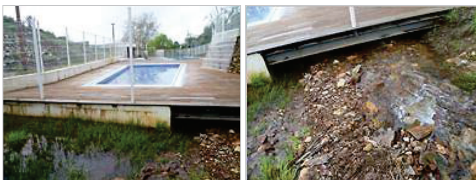
Figura 30 - Fotografias do deck sobre-elevado à ribeira a montante das piscinas de Alegrete
