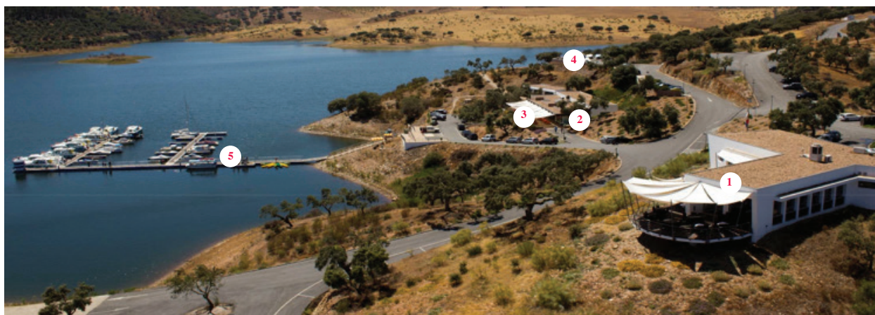
Figura 69- Restaurante (1), loja de conveniência (2), bar (3), oficina (4) e ancoradouro (5), fonte: Amieira Marina
