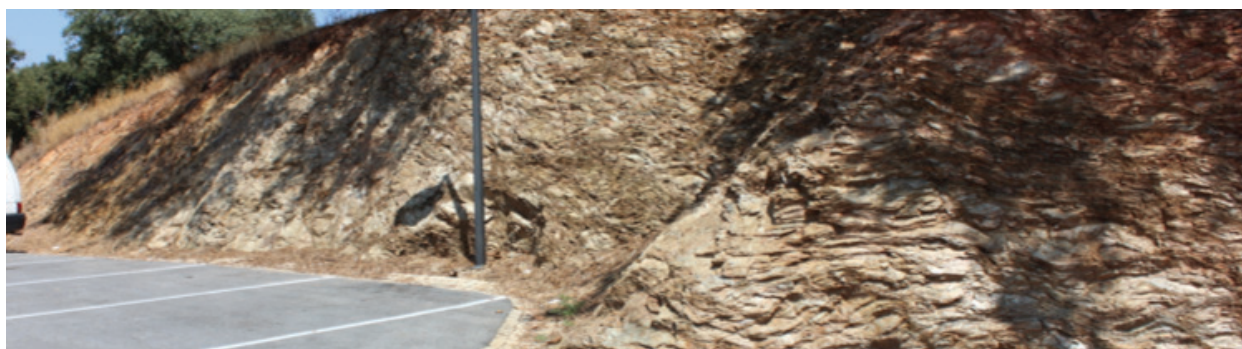
Figura 96-Aspecto actual dos taludes, fonte: autor
