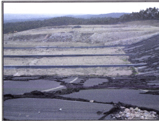
Fotografia 4.3 – Panorâmica geral do Aterro Sanitário (Janeiro de 2006).
