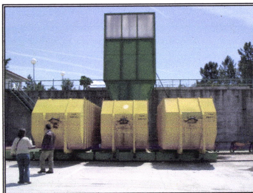
Fotografia 4.5 – Aspecto geral (zona inferior) da estação de transferência de Proença-a-Nova.
