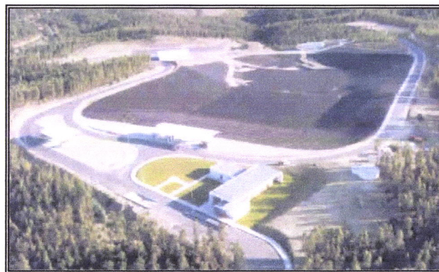
Fotografia 4.1 – Panorâmica aérea do aterro sanitário no final da sua construção. Fonte: Zagope – Construções e Engenharia S.A.
