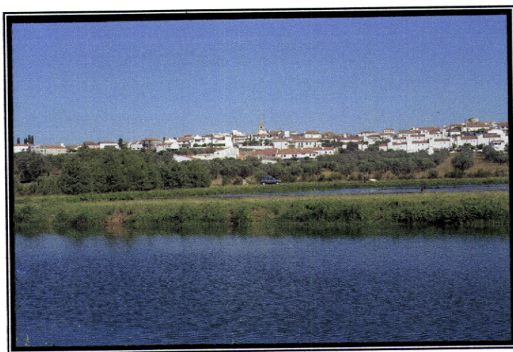
Figura 2.12 - ETAR de Monforte. Perspectiva geral em 17.06.98
