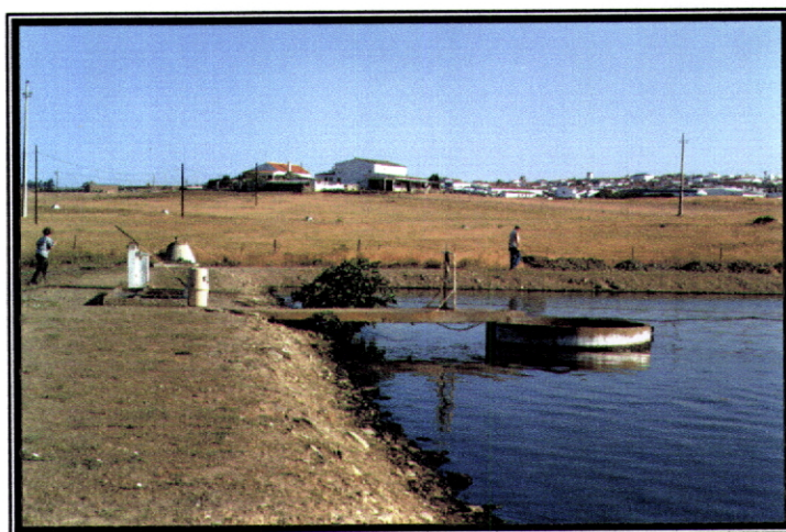
Figura 2.9 - ETAR Castro Verde. Visualização da lagoa anaeróbia e do amostrador automático de amostras compostas em 15.07.98
