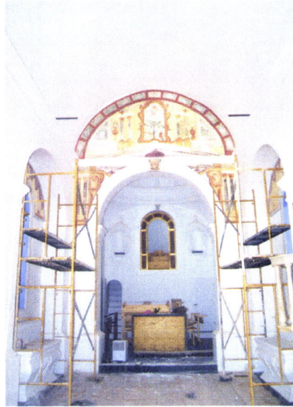
Foto 35 – Aplicação da pintura mural na nova igreja Matriz
