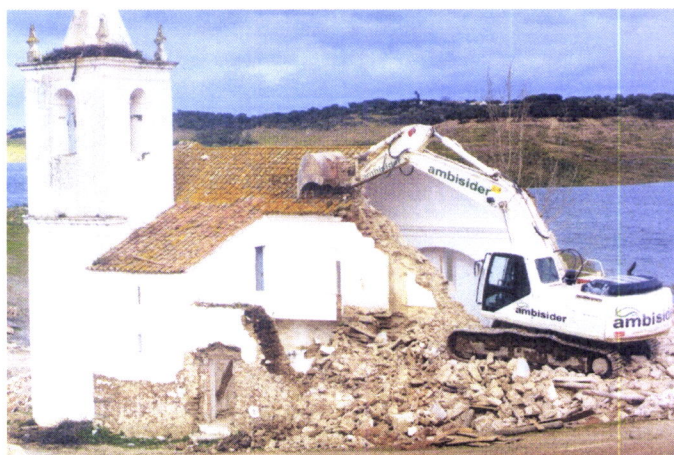
Foto 37 – Demolição da antiga Igreja Paroquial da Luz
