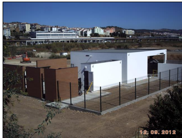
Figura 3.16 – Estação elevatória de Icesa.
