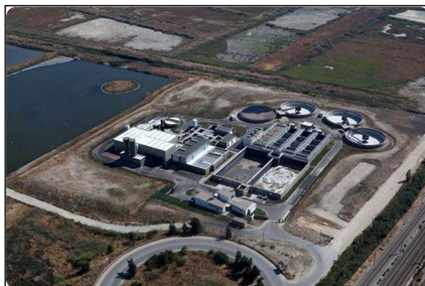
Figura 3.3 - Vista aérea da ETAR de Alverca.
