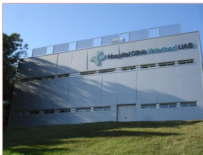
Figura 1. Vista geral das instalações do HCV da Universidade Autònoma de Barcelona. Imagem gentilmente cedida pelo HCV-UAB.
