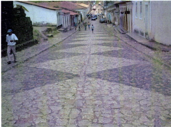
Fig. 60- Alcântara. Calçada da Rua Direita.
