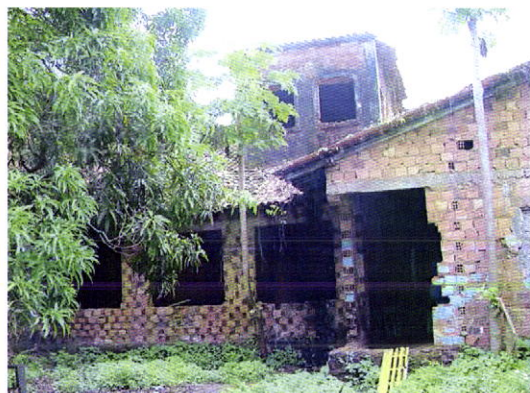
Fig. 86 - Alcântara. Ladeira do Jacaré. Vista interna do imóvel nº 69.
