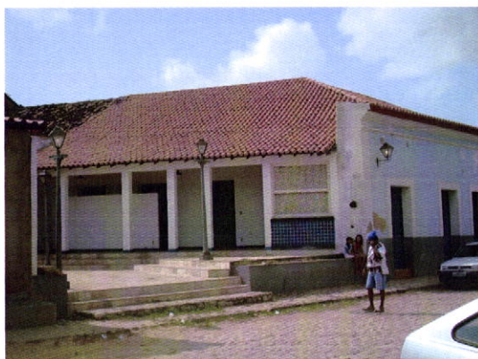
Fig. 80 - Alcântara. Porto do Jacaré. Praça adjacente ao Terminal hidro-rodoviário.
