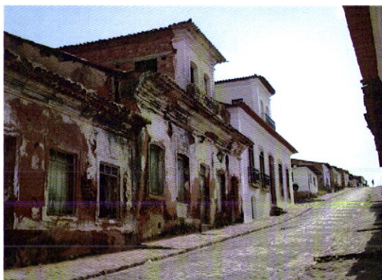
Fig. 85 - Alcântara. Ladeira do Jacaré. Imóvel nº 69.
