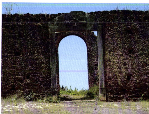
Fig. 131 - Alcântara. Rua Direita. Ruínas da Igreja de São Francisco
