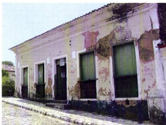
Fig. 83 - Alcântara. Ladeira do Jacaré. Imóvel nº 26.
