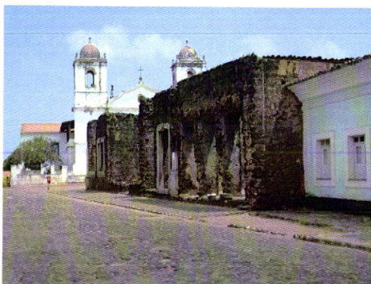
Fig. 124 - Alcântara. Alçado principal da ruína do Palácio do Barão de Mearim.
