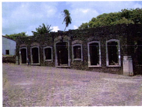
Fig. 127 - Alcântara. Alçado principal do Palácio do Barão de Pindaré.
