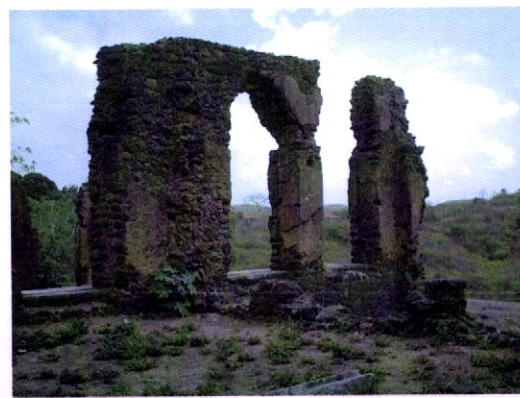
Fig. 55- Alcântara. Ruína da Rua da Amargura
