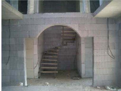
Fig. I.69 – Arco concluído (ARGISOL, 2010).
