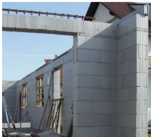
Fig. I.23 – Colocação de armadura no elemento de lintel (ARGISOL, 2010).
