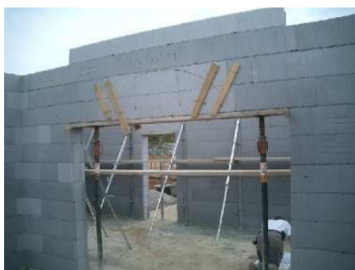
Fig. I.68 – Conjunto de arco, previamente montado, colocado na parede e escorado (ARGISOL, 2010).
