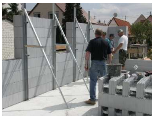
Fig. I.31 – Escoramento de parede semi-levantada (ARGISOL, 2010).
