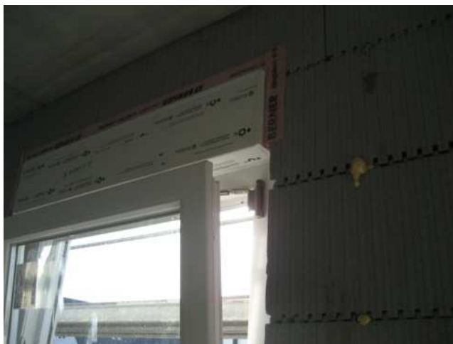
Fig. I.30 – Caixilharia com caixa de estore integrada colocada em obra.
