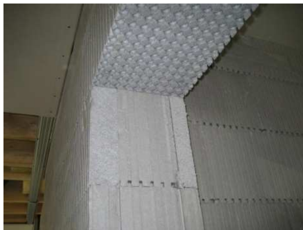
Fig. I.24 – Base de um elemento de lintel já betonado colocado num vão.
