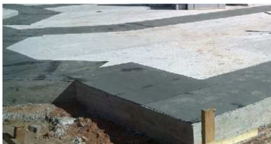
Fig. I.10 – Impermeabilização na zona das paredes (ARGISOL, 2010).
