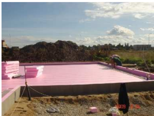
Fig. 4.1 – Execução de cofragem em XPS de laje de fundação (ARGISOL, 2010).
