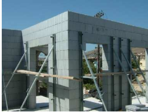
Fig. I.32 – Escoramento de parede completa (ARGISOL, 2010).
