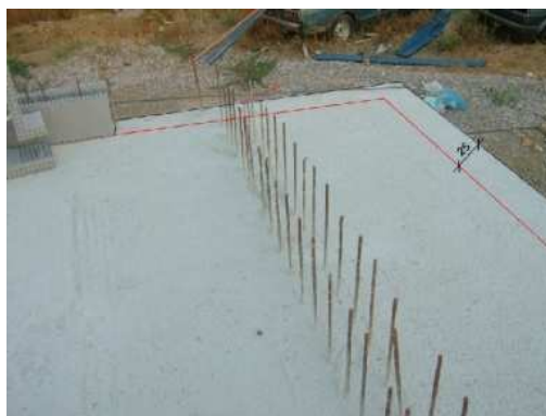
Fig. I.6 – Marcação das paredes (ARGISOL, 2010).
