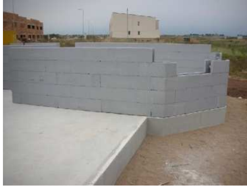
Fig. I.3 – Primeiras fiadas de parede sobre laje de fundação (ARGISOL, 2010).
