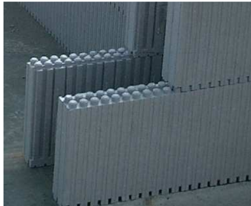
Fig. I.12 – Elementos intercalados com visualização das ranhuras (ARGISOL, 2010).
