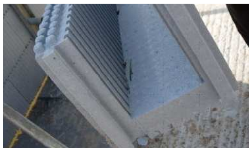
Fig. I.20 – Elemento de lintel visualização da zona de encaixe (macho) tipo malhete em cauda de andorinha (ARGISOL, 2010).
