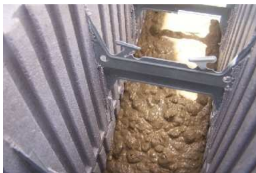
Fig. I.35 – Betão no interior da cofragem (ARGISOL, 2010).
