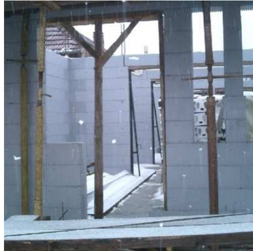
Fig. I.79 – Construção de Inverno com neve (ARGISOL, 2010).
