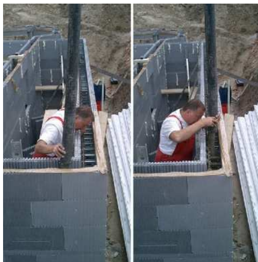
Fig. I.38 – Betonagem com bomba (ARGISOL, 2010).
