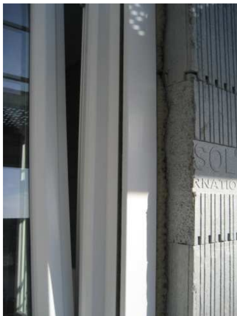
Fig. I.19 – Caixilharia instalada directamente sobre o fecho de parede.
