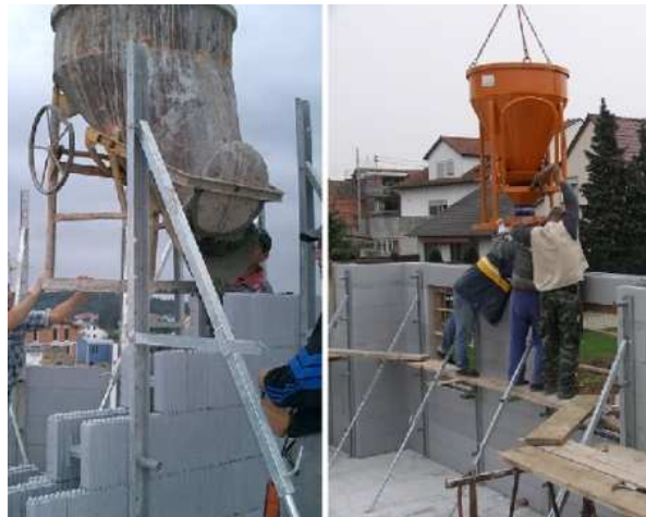
Fig. I.37 – Betonagem com grua e respectivo balde (ARGISOL, 2010).
