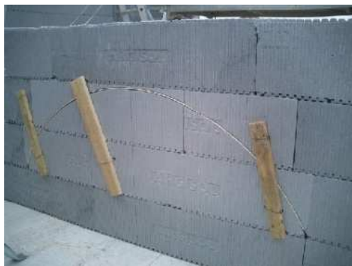
Fig. I.67 – Placa em fibra de madeira colocada na ranhura e devidamente fixa no sítio (ARGISOL, 2010).
