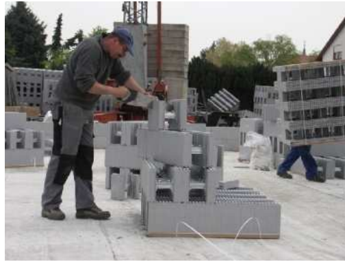
Fig. I.11 – Corte de um elemento com serra de mão (ARGISOL, 2010).
