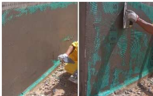
Fig. I.82 – Execução de recobrimento exterior com tela/rede de vidro (ARGISOL, 2010).
