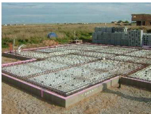
Fig. 4.2 – Colocação de armadura na laje de fundação (ARGISOL, 2010).
