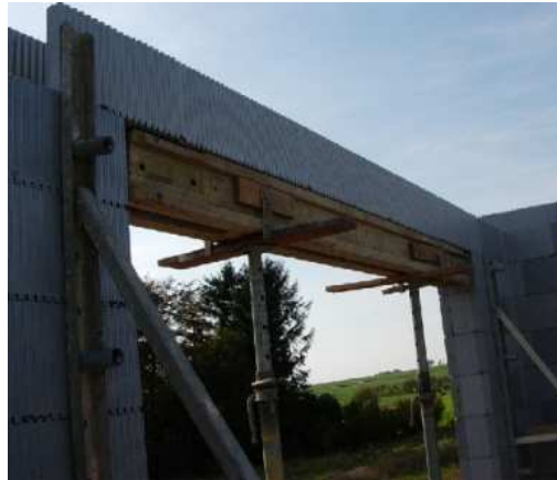
Fig. I.22 – Escoramento de elemento de lintel com viga de madeira e escoras metálicas extensíveis (ARGISOL, 2010).
