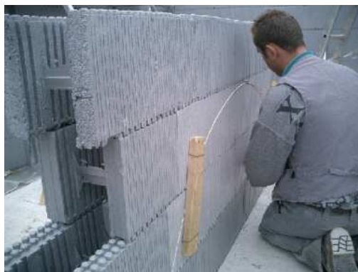
Fig. I.66 – Colocação de placa em fibra de madeira na ranhura do arco (ARGISOL, 2010).
