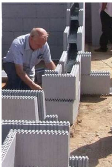
Fig. I.15 – Colocação de elementos (ARGISOL, 2010).
