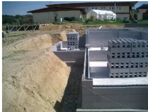
Fig. I.73 – Primeiras fiadas numa parede de cave (ARGISOL, 2010).
