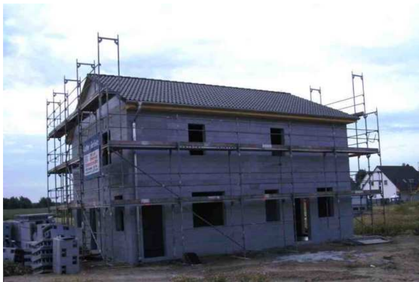
Fig. I.1 – Construção de um edifício de habitação com cofragens modulares em EPS, Berlim.
