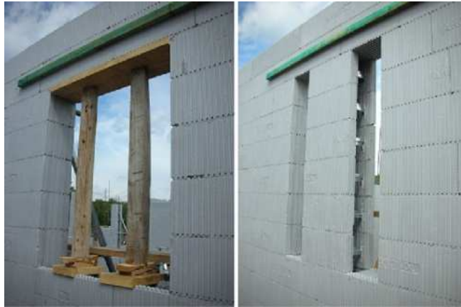
Fig. I.25 – Escoramentos com barrotes de madeira e com elementos de cofragens correntes (ARGISOL, 2010).
