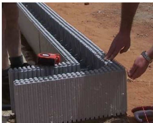
Fig. I.9 – Colocação da primeira fiada (ARGISOL, 2010).
