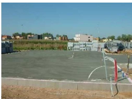
Fig. 4.3 – Laje de fundação betonada (ARGISOL, 2010).
