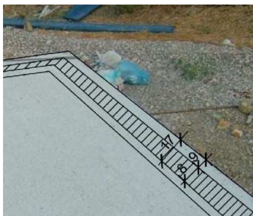
Fig. I.5 – Marcação do ferro de arranque (ARGISOL, 2010).
