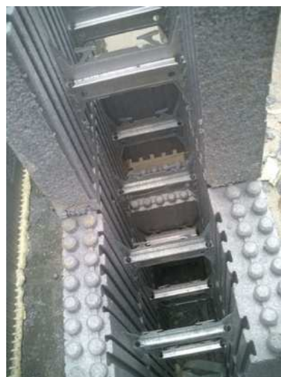
Fig. I.13 – Elementos intercalados com corte no elemento superior (ARGISOL, 2010).
