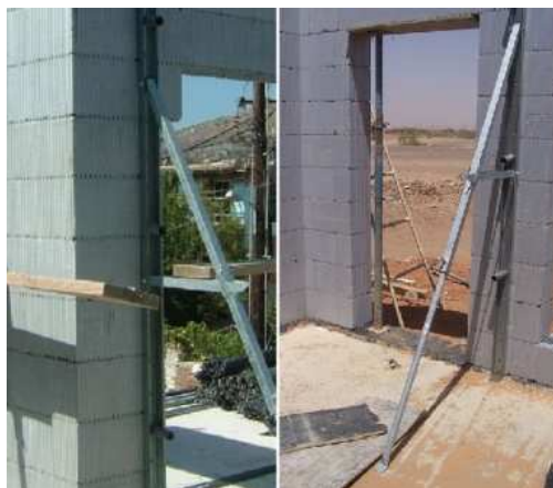
Fig. I.34 – Pormenor do escoramento com a visualização dos parafusos de fixação (ARGISOL, 2010).
