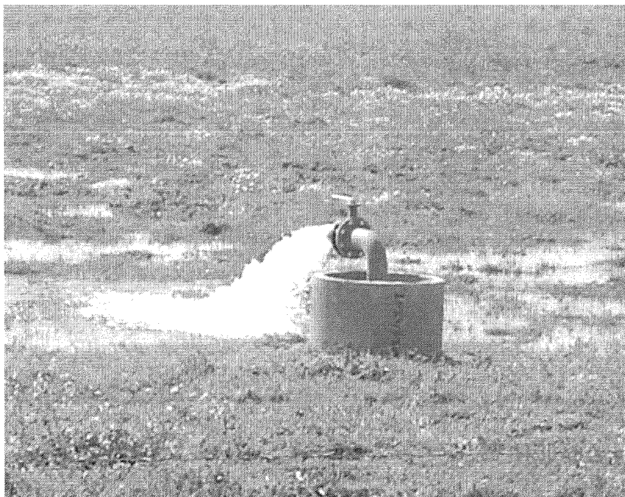
Fotografia nº 28 – Sistema de rega da Infra-estrutura 12
