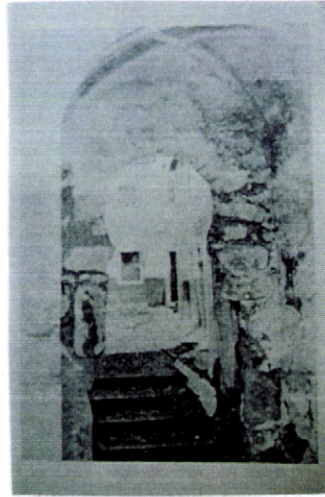
Fig. 30 – 1ª Cintura árabe. Porta da Alcáçova, antes de ser demolida
