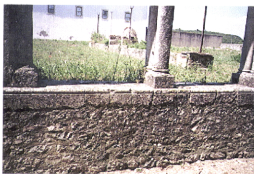
Foto 83 – Pormenor construtivo do embasamento Da arcaria do claustro.
