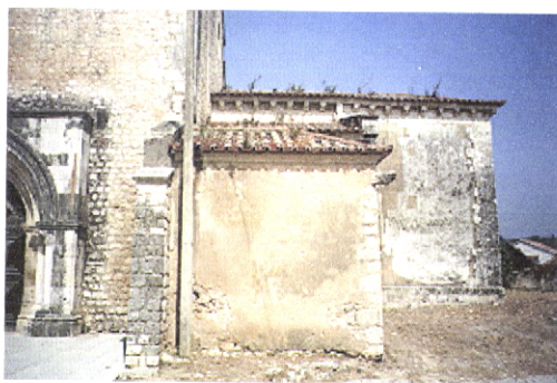
Foto 78 – Embasamento no alçado sul da capela-mor.
