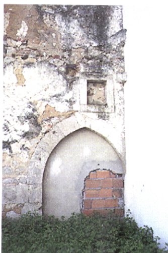
Foto 39 – Vão de porta entaipado no alçado nascente do muro de ligação entre os antigos edifícios do refeitório e dormitório.
