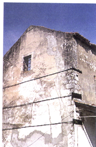
Foto 108 – Pormenor de uma fenda vertical do alçado norte do dormitório.
