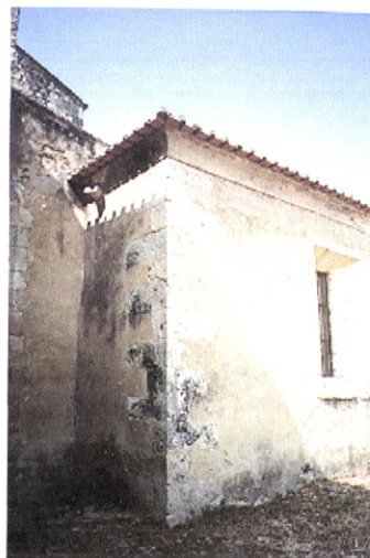
Foto 21 – Pormenor da empena sul da sacristia com gárgula localizada na engra entre este edifício e a capela lateral norte.
