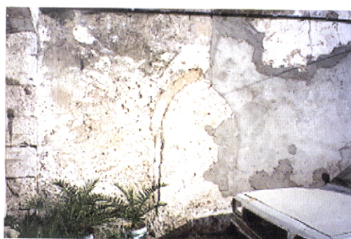
Foto 31 – Vão de porta sob o reboco deteriorado da face exterior do alçado norte do dormitório.
