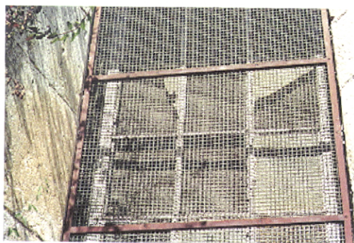
Foto 123 – Vidros partidos na janela do alçado sul da capela-mor.
