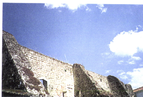
Foto 110 – Pormenor da junta de ligação do contraforte com a parede poente do dormitório.
