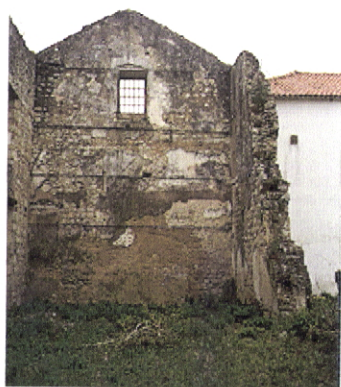
Foto 30 – Face interior atirantada do alçado norte do antigo dormitório.
