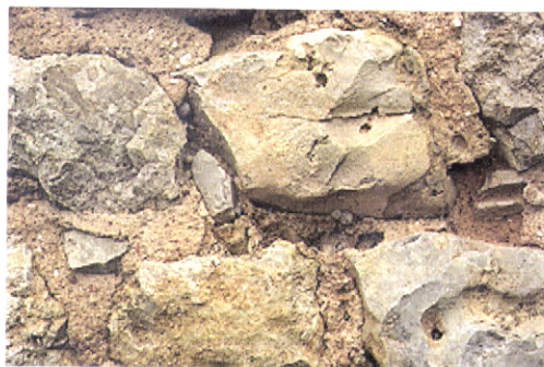
Foto 77 – Utilização do calcário margoso na alvenaria da casa capitular.
