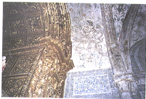
Foto 94 – Pormenor da deterioração das pinturas do tecto abobadado da capela-mor da igreja.
