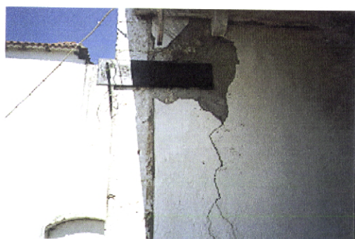
Foto 109 – Pormenor de uma fenda vertical no alçado poente do dormitório.
