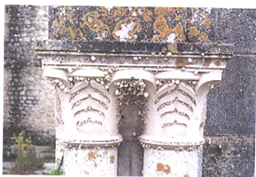
Foto 74 – Distinção entre a pedra utilizada na origem e aquela que foi posteriormente utilizada na intervenção da DGEMN.
