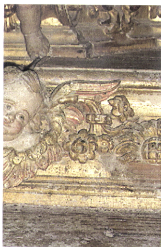
Foto 116 – Vestígios da presença activa do caruncho no altar em talha situado na nave lateral norte do templo de fora .
