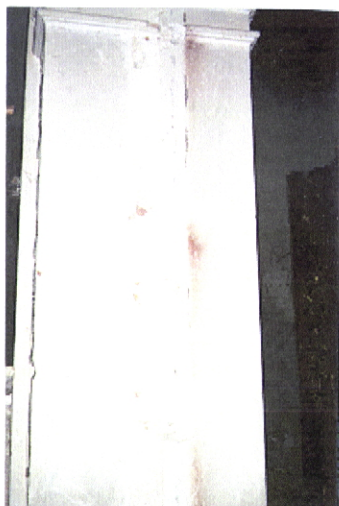
Foto 12 – Pormenor da parede divisória da igreja com vestígios do encaixe do antigo gradeamento.
