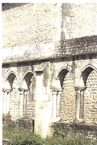
Foto 86 – Pormenor de um contraforte no extradorso da arcaria do claustro
