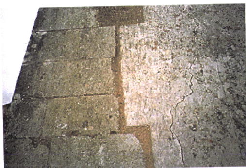
Foto 105 – Pormenor da fenda vertical na face exterior do alçado nascente da capela-mor.
