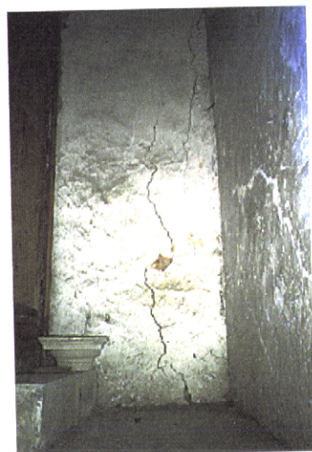
Foto 106 – Fenda vertical na face interior do alçado nascente da capela-mor da igreja.
