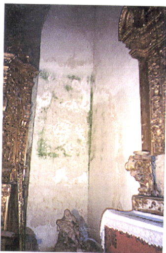
Foto 96 – Mancha de humidade no canto sudoeste da nave lateral sul da igreja.
