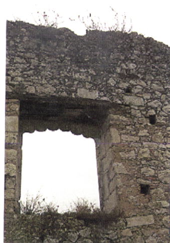
Foto 91 – Pormenor construtivo de um vão no intradorso do alçado poente do antigo dormitório.
