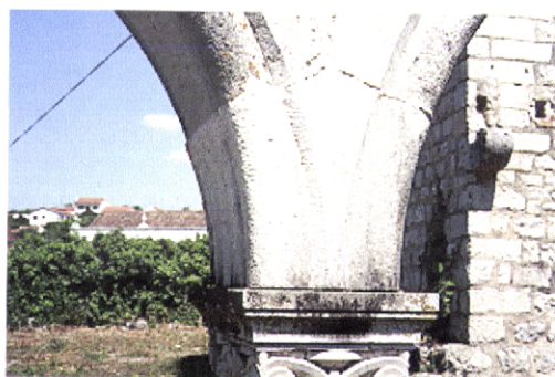
Foto 101 – Pormenor das juntas erodidas no extradorso da arcaria da galeria do capítulo do claustro.
