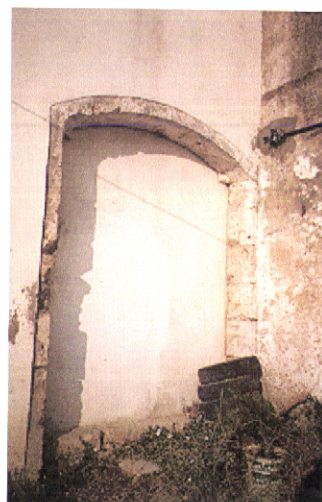
Foto 40 – Vão de porta entaipado no alçado poente do muro de ligação entre os antigos edifícios do refeitório e dormitório
