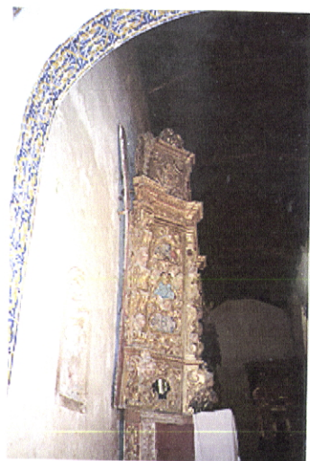
Foto 98 – Altar de talha em risco de queda, situado na nave lateral sul da igreja.
