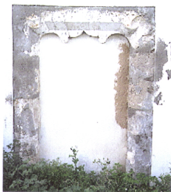
Foto 29 – Vão de porta entaipado no alçado sul do antigo refeitório.
