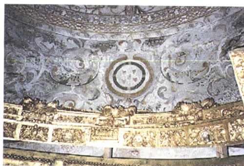
Foto 104 – Fenda transversal no intradorso da abóbada da capela-mor da igreja.
