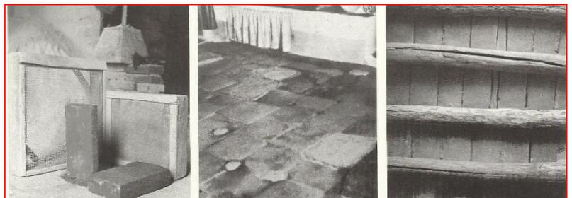
30 - Construção em Adobe: Extração; Preparação; Moldagem; Aperfeiçoamento; Secagem; Forno; Tijolo de alvenaria e tijoleira de pavimento dimensionados em palmos craveiros segundo vestígios arqueológicos de Monsaraz, séc. XVI-XVII; o tijolo e a tijoleira; exemplos de aplicação em piso térreo e em piso elevado.
