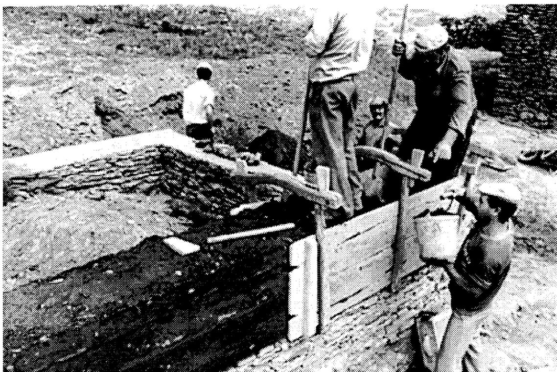
Os taipais utilizados neste sistema construtivo são feitos de madeira, em pranchas com pegas, tendo as medidas aproximadas de 2,00 x 0,50m, sendo colocados um do outro a uma distância que pode variar entre os 45 e os 70 centímetros, consoante o comprimento das agulhas e o desejo do dono da obra.
