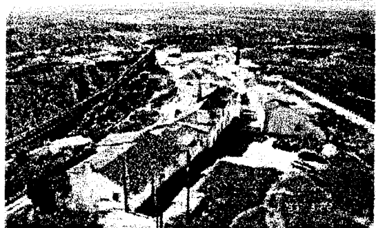
Vista sobre o troço sul da povoação com a igreja Matriz ao fundo.
