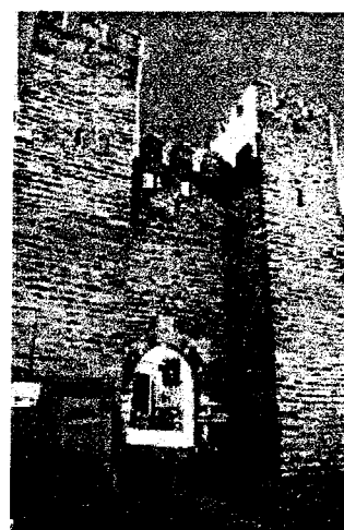
A Porta Legal, ou principal, que dava acesso à Praça da Vila, no interior da cerca.
