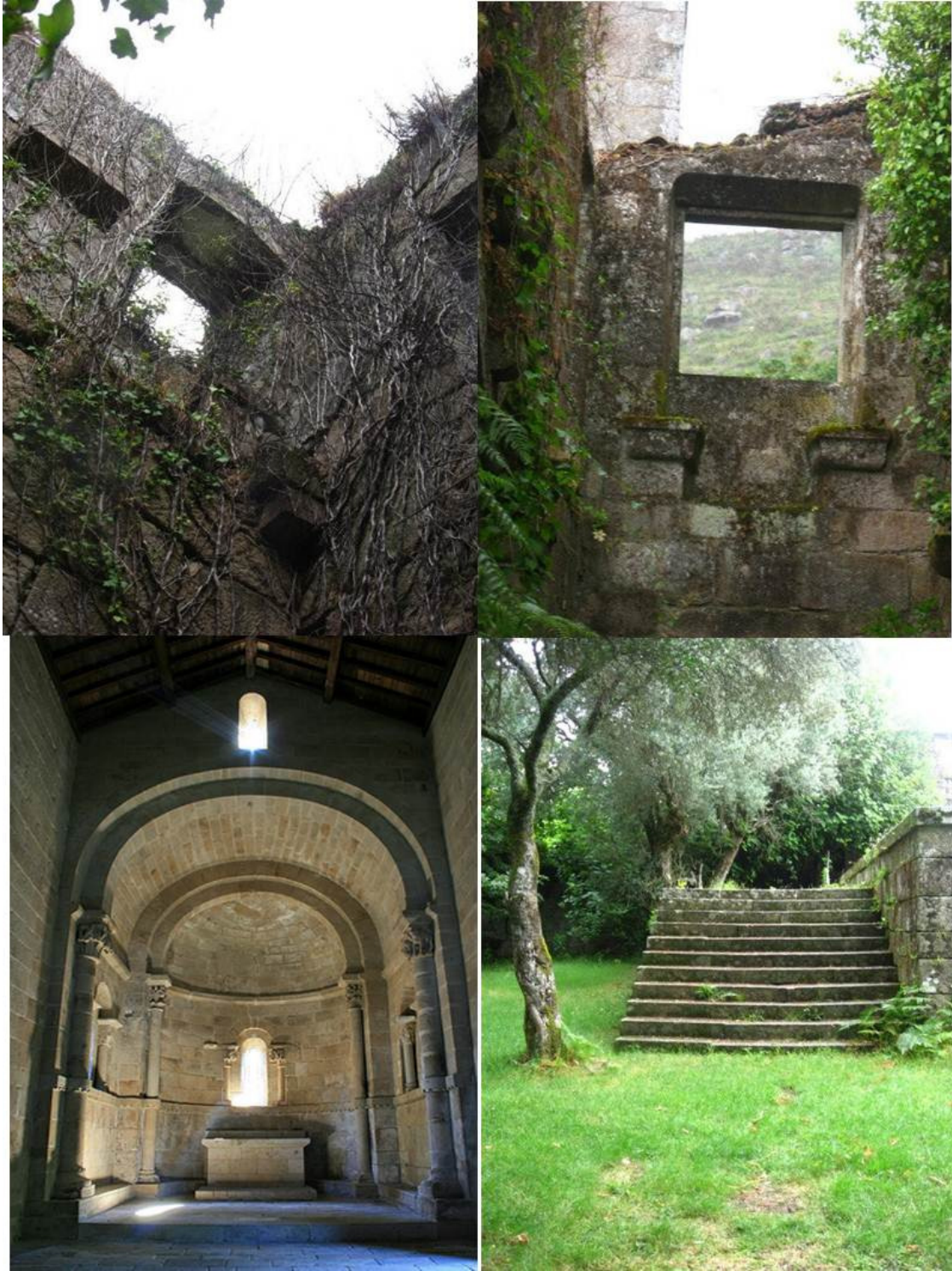
Ilustração 12 – Em cima, Espaço Residencial em avançado estado de ruína. Em baixo, escada de acesso à Igreja e Interior da Igreja. 10
