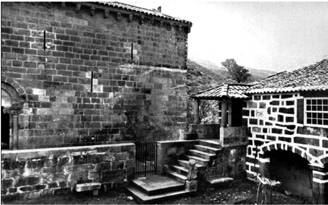
Ilustração 3 – Fachada Norte antes e depois da desanexação. 2
