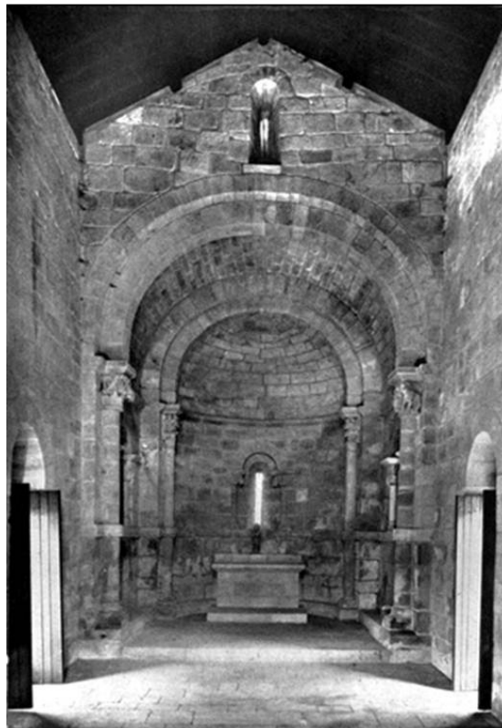
Ilustração 7 – Interior da Igreja. Destaca-se a eliminação total da carga decorativa, assim como de todo o reboco que revestia as paredes. 5
