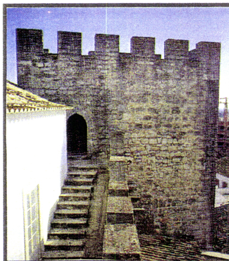
Acesso à Sala da Torre 3
