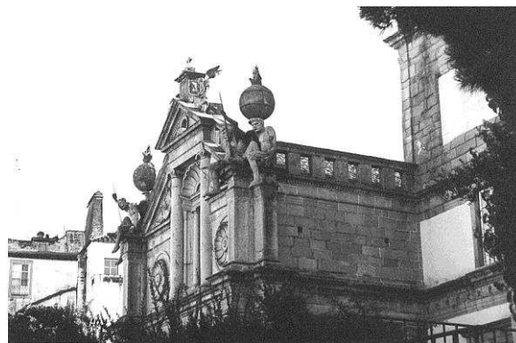
Figura 5 – Vista lateral do frontão da igreja de Nossa Senhora da Graça.
