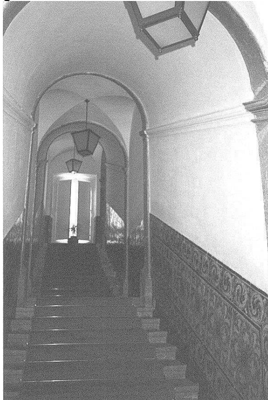
Figura 12 – Vista do interior da escadaria de acesso ao primeiro piso.
