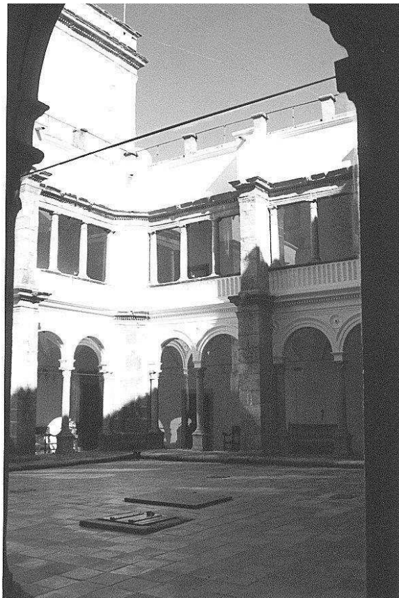
Figura 10 – Vista do interior do claustro do convento.
