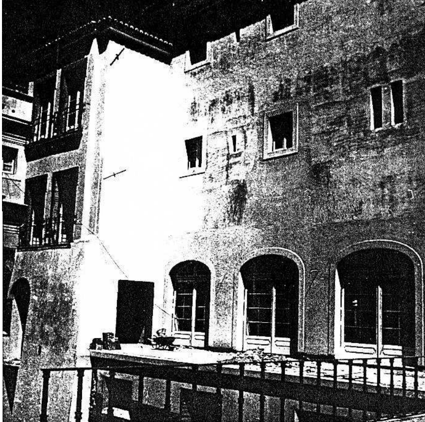
Figura 15 – Fotografia antiga do alçado sul – DGEMN.
