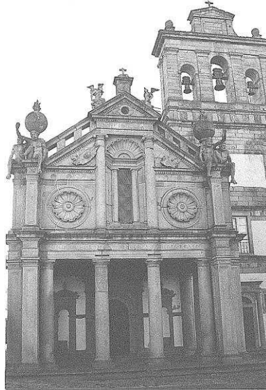
Figura 4 – Vista da fachada principal de igreja de Nossa Senhora da Graça.
