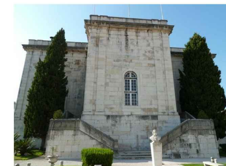
77. Reservatório Mãe d'Água, Lisboa.
