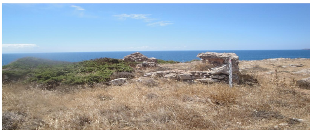
Ruínas da estrutura do Corpo da Guarda da Bateria
