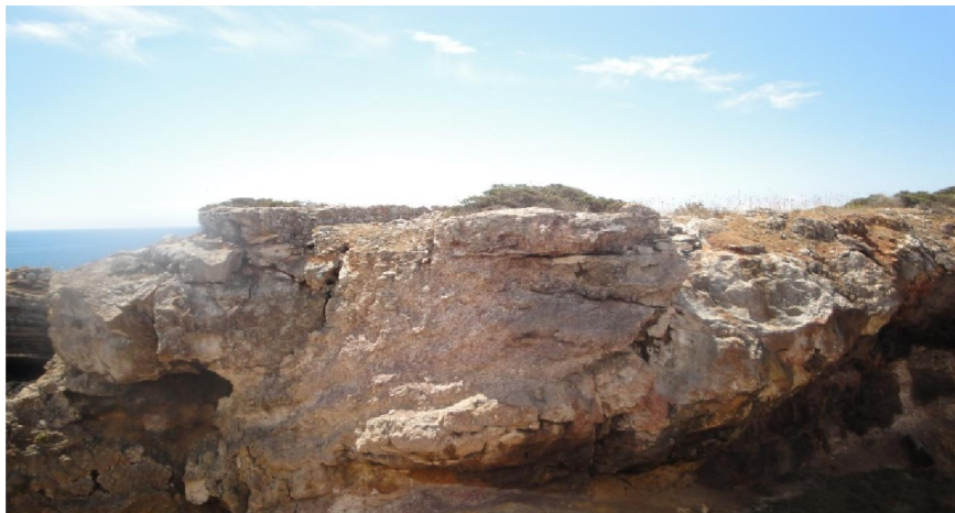
Ruínas da Estrutura do Forte
