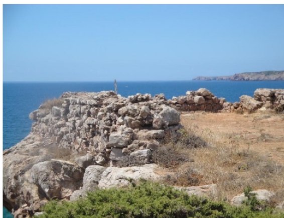
Muro Exterior da bateria
