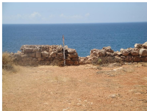
Muro de protecção da Bateria
