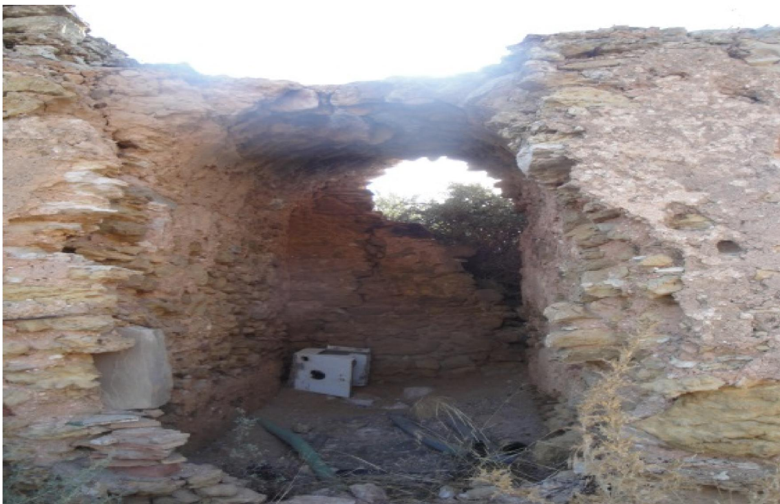
Interior da Fortificação
