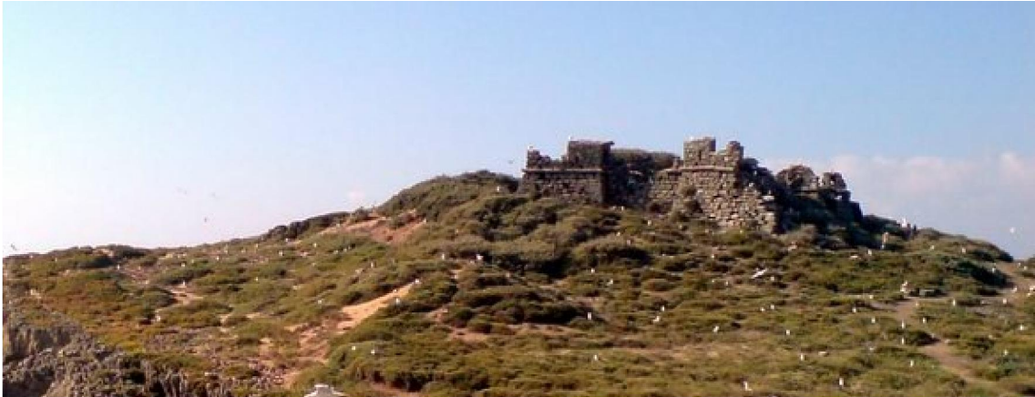
Fortim do Pessegueiro
