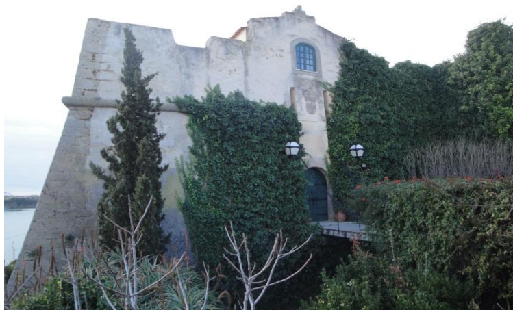
Forte S. Clemente - ponte levadiça
