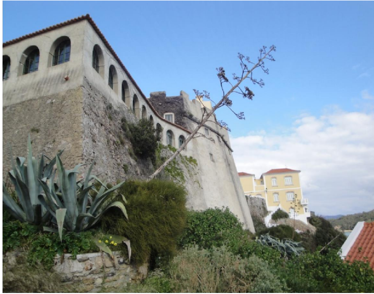
Forte S. Clemente – Muro anguloso da praça baixa
