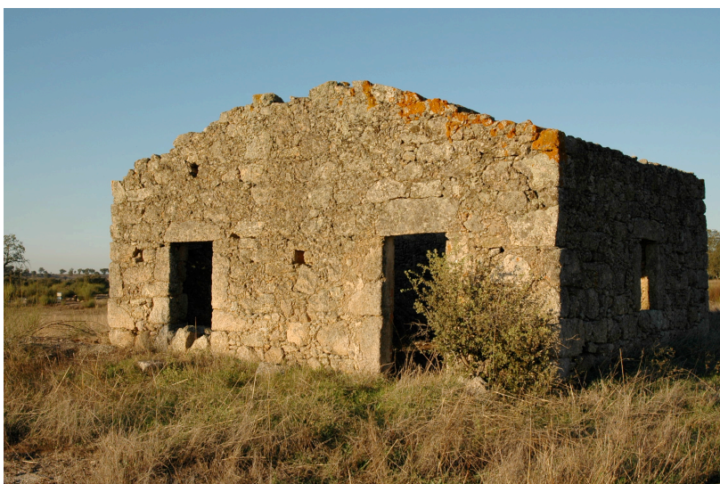
Lage de Santo Estêvão (07.13): vista da construção existente no local. A mancha de materiais encontra-se nas traseiras do edifício.
