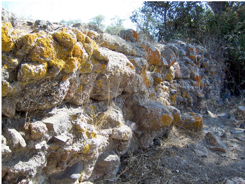
Tapada Grande (06.10): vista do paredão da barragem.
