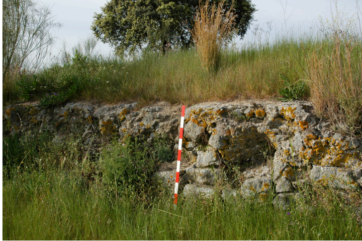
Casa de Alvalade (01.08): lanço melhor conservado do grande muro existente no local.
