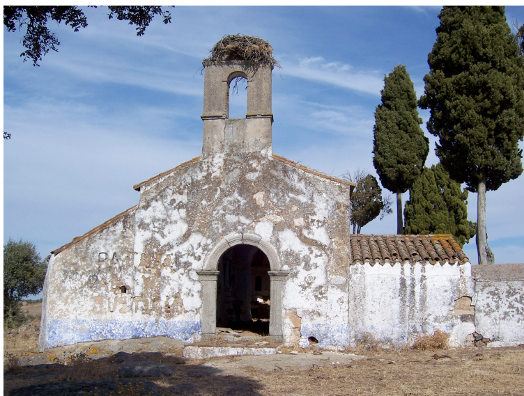
S. Bartolomeu (02.40): fachada do templo que também reaproveita alguns materiais romanos.
