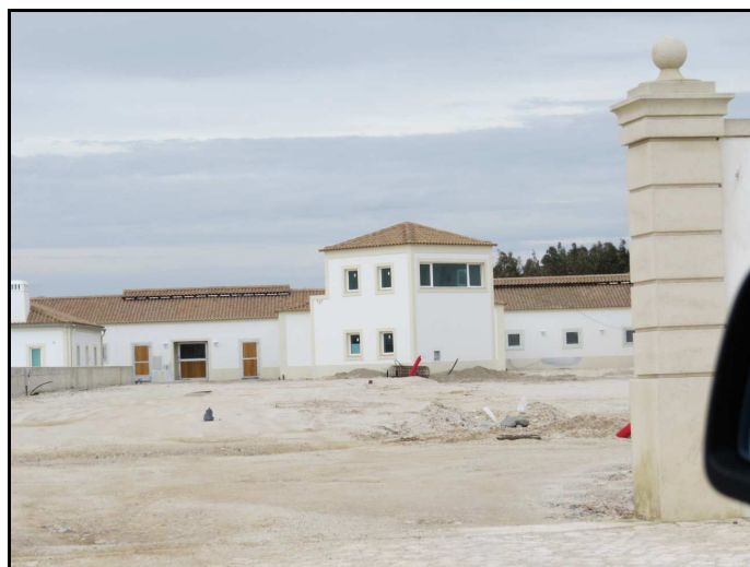
Figura 34 – Construção do Centro Equestre do empreendimento Quintas de Óbidos (Autor: Liliana Ramalho, março de 2013)
