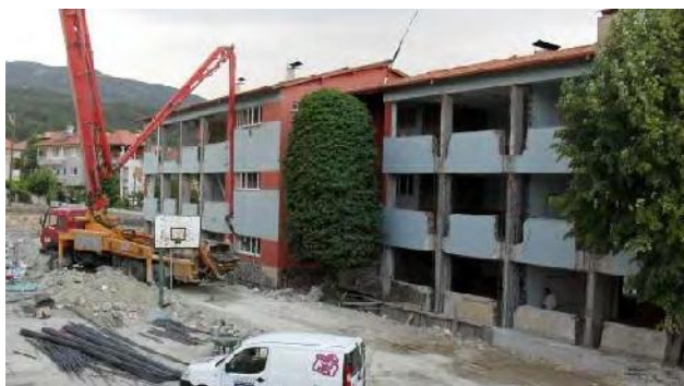
Figura 2.1 – (a) Impacto da execução de um encamisamento de betão armado, na utilização de um edifício (Foto de Ahmet Sarı in) e (b) demolições necessárias para intervir num pilar (Farmergroup.com).
