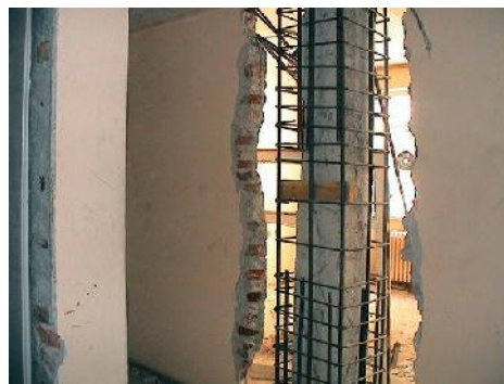
Figura 2.1 – (a) Impacto da execução de um encamisamento de betão armado, na utilização de um edifício (Foto de Ahmet Sarı in) e (b) demolições necessárias para intervir num pilar (Farmergroup.com).
