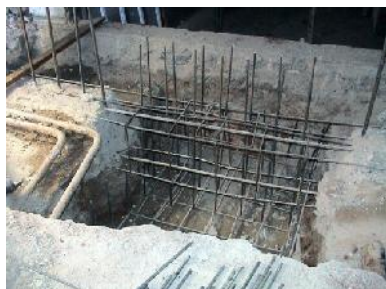
Figura 3.2 - Reforço da fundação: ligação entre sapatas vizinhas (buildingresearch.com.np)
