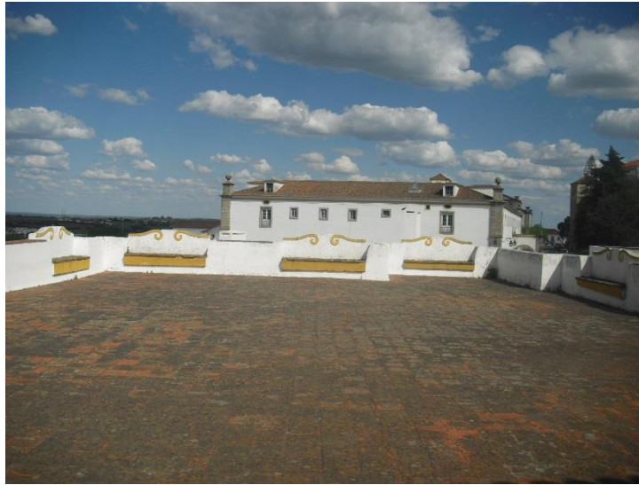
Fig. 21 A varanda retangular do antigo convento de Santa Mónica. Fonte: elaboração própria (Novembro de 2013)
