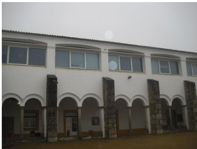
Fig. 35 O lanço mais antigo do Claustro. Fonte: elaboração própria (Novembro de 2013)
