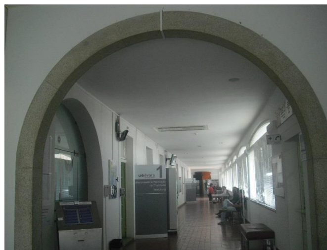
Fig. 28 Arco de volta perfeita em granito. No lado esquerdo o arco que dava acesso à igreja.
