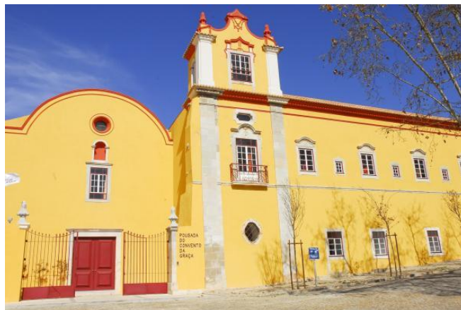
Fig.6 A Pousada instalada na antiga instalação do convento de Nossa Senhora da Graça de Tavira. Fonte: http://www.cm-tavira.pt/site/content/igrejas (Abril de 2013)
