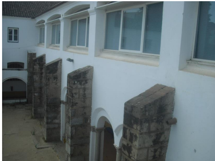
Fig. 29 Vista do exterior da ala nascente do Claustro e do antigo dormitório do convento. Fonte: elaboração própria (Novembro de 2013)
