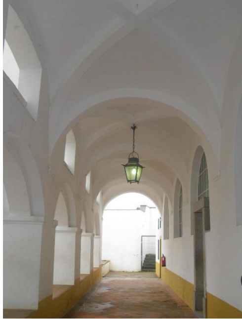
Fig. 37 O lanço Sul com abóbadas de cruzamento ogival no seu interior. Fonte: elaboração própria (Novembro de 2013)
