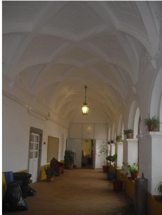
Fig. 39 O lanço Norte com abóbada artesoadada (semelhante à da Casa do Capítulo, hoje ocultas). Fonte: elaboração própria (Novembro de 2013)
