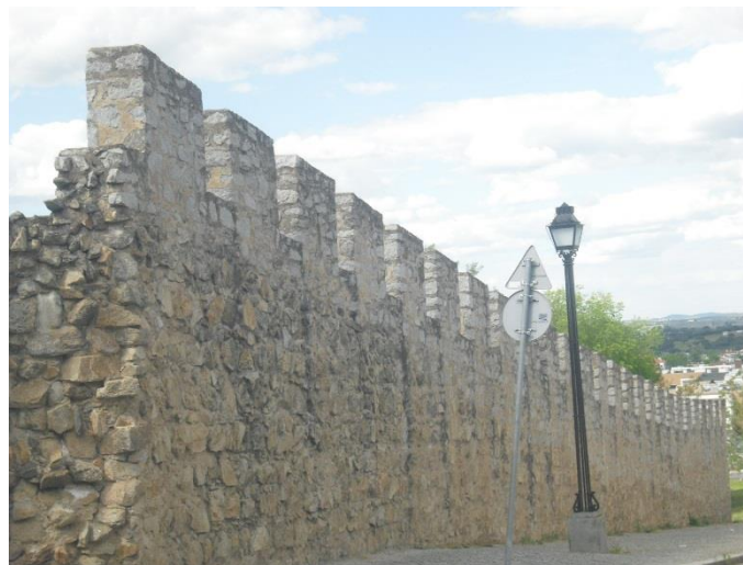
Fig.10 A muralha fernandina junto à Cerca do convento de Santa Mónica. Fonte: elaboração própria (Novembro de 2013)
