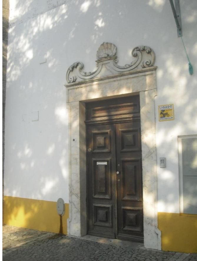
Fig. 27 Portal de acesso à Escola Primária de S. Mamede, rés-do-chão do antigo convento de Santa Mónica.
