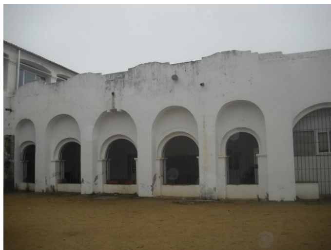
Fig. 38 Lanço Norte do Claustro. Fonte: elaboração própria (Novembro de 2013)
