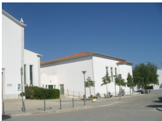
Figura 40 - Vista lateral da fachada da igreja, ao fundo o salão polivalente.
