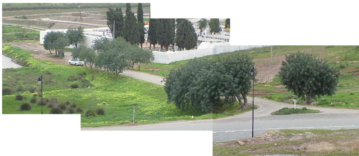
Figura 29 - Vista da entrada do cemitério de Castro Marim antes da intervenção.
