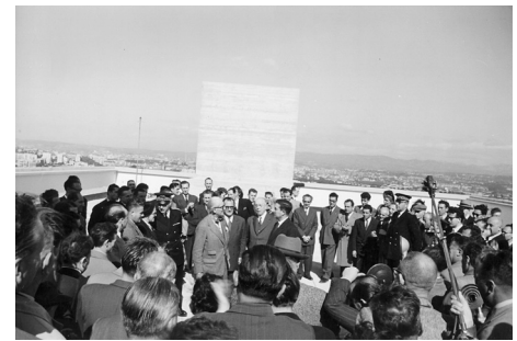
[FIG. 31] AZOTEA EL DÍA DE LA INAUGURACIÓN OFICIAL DE LA UHM (14 DE OCT. DE 1952, FLC L1-16-37). ©FLC/VEGAP 2012.
