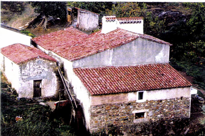
Figura 12 - Vale Lourenço. Azenha.
