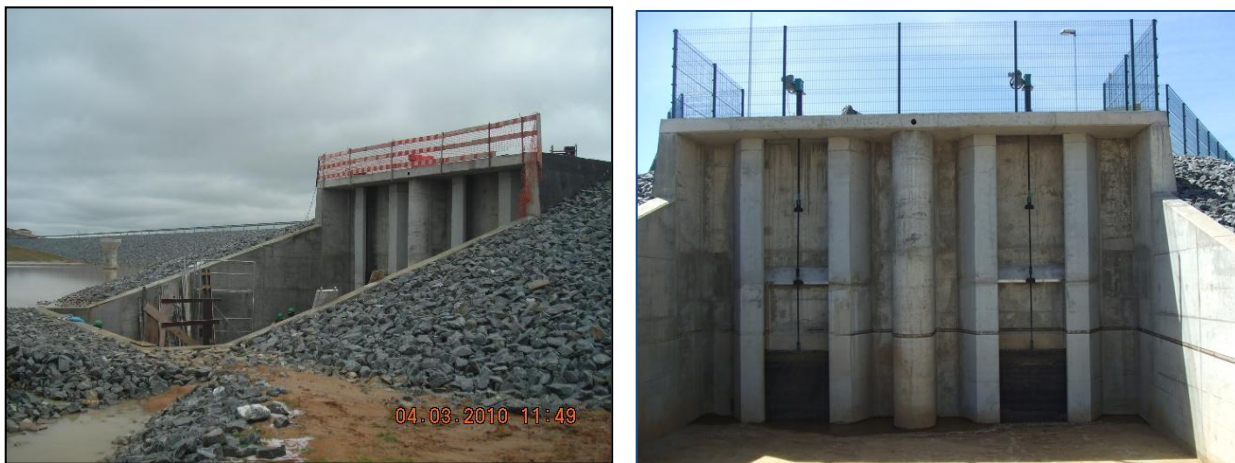
Figura 1 e 2 – Estrutura de tomada de Água - Comportas
