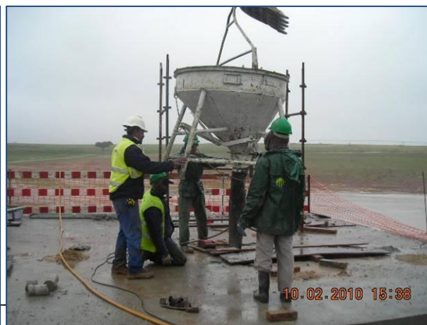
Figura. 9 – Betonagem para fixação dos aros das comportas murais da Estrutura de Tomada de Água
