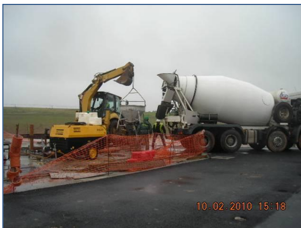
Figura. 8 – Descarga do betão para o balde
