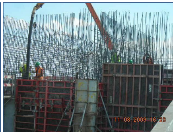
Figura. 7 – Betonagem do muro lateral esquerdo da Estrutura de Tomada de Água a partir da auto-bomba
