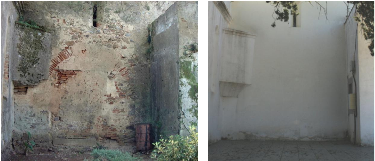
Ilustração 66 - Montemor-o-Novo. Antiga igreja de São Tiago. Vista da zona do arco antes da intervenção (à esquerda) e depois da intervenção (à direita)
