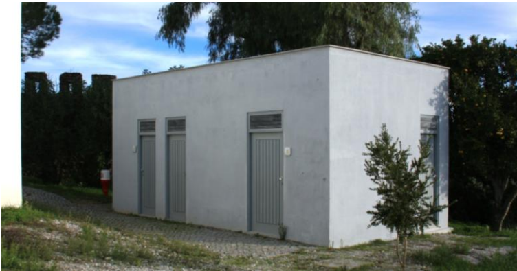
Ilustração 72 - Montemor-o-Novo. Aspecto actual do edifício das instalações sanitárias exteriores à antiga igreja de São Tiago.
