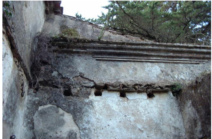
Ilustração 63 - Montemor-o-Novo. Antiga igreja de São Tiago. Estado de degradação no anexo no lado norte, antes da intervenção. À direita podem-se observar os orifícios de entrega do antigo vigamento da estrutura da cobertura entretanto desaparecida.
