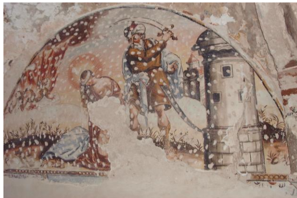
Ilustração 69 - Montemor-o-Novo. Antiga igreja de São Tiago. Picagem do reboco na zona de uma pintura mural.
