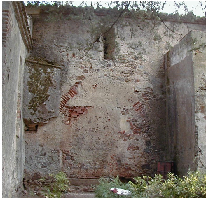
Ilustração 39 - Montemor-o-Novo. Antiga igreja de São Tiago. Porta emparedada no alçado norte – Vista exterior (situação anterior à intervenção).
