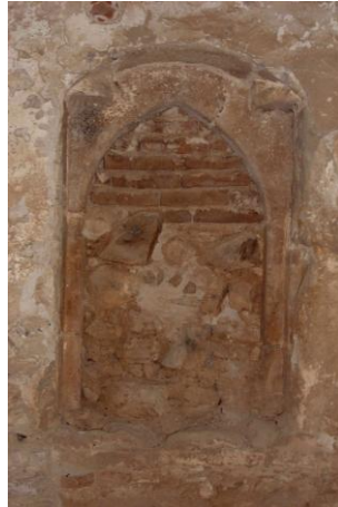
Ilustração 42 - Montemor-o-Novo. Antiga igreja de São Tiago. Portal de granito emparedado, visto do interior - (situação anterior à intervenção).
