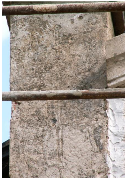
Ilustração 41 - Montemor-o-Novo. Antiga igreja de São Tiago. Espada em esgrafito encontrada no campanário - (situação anterior à intervenção).
