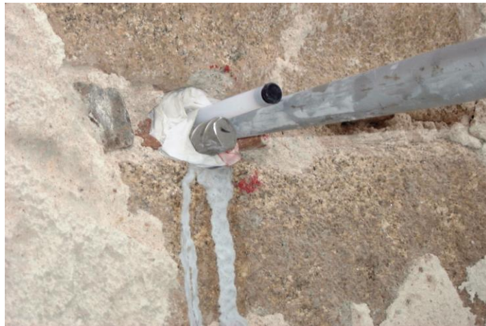
Ilustração 68 - Montemor-o-Novo. Antiga igreja de São Tiago. Pormenor da pregagem
