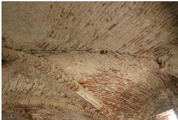
Ilustração 61 - Montemor-o-Novo. Antiga igreja de São Tiago. Aspecto da abóbada junto ao coro alto (situação anterior à intervenção).
