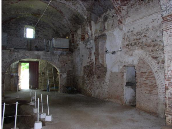
Ilustração 60 - Montemor-o-Novo. Antiga igreja de São Tiago. Vista parcial do interior (situação anterior à intervenção).
