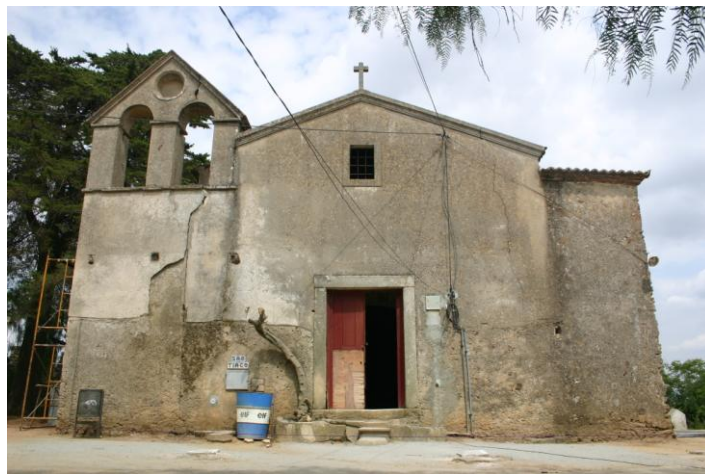
Ilustração 38 - Montemor-o-Novo. Antiga igreja de São Tiago. Fachada desprovida parcialmente de reboco (situação anterior à intervenção).
