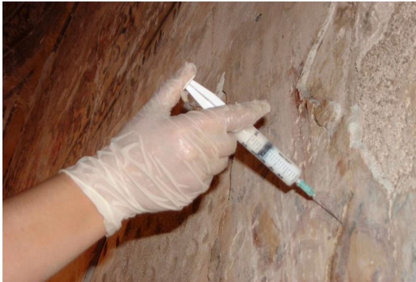
Ilustração 70 - Montemor-o-Novo. Antiga igreja de São Tiago. Injecção de fixador no suporte das pinturas.
