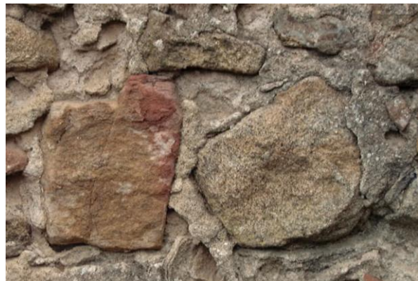
Ilustração 50 - Montemor-o-Novo. Antiga igreja de São Tiago. Mancha, sujidade e alteração cromática - (situação anterior à intervenção).
