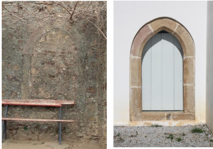
Ilustração 65 - Montemor-o-Novo. Antiga igreja de São Tiago. Portal de granito antes da intervenção (à esquerda) e depois da intervenção (à direita).
