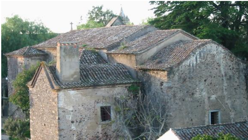
Ilustração 62 - Montemor-o-Novo. Antiga igreja de São Tiago. Cobertura da igreja - (situação anterior à intervenção).
