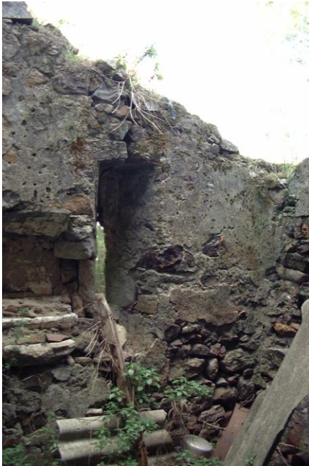
Ilustração 63 - Montemor-o-Novo. Antiga igreja de São Tiago. Estado de degradação no anexo no lado norte, antes da intervenção. À direita podem-se observar os orifícios de entrega do antigo vigamento da estrutura da cobertura entretanto desaparecida.
