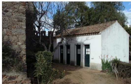
Ilustração 45 - Montemor-o-Novo. Antiga igreja de São Tiago. Instalações sanitárias exteriores. (situação anterior à intervenção).
