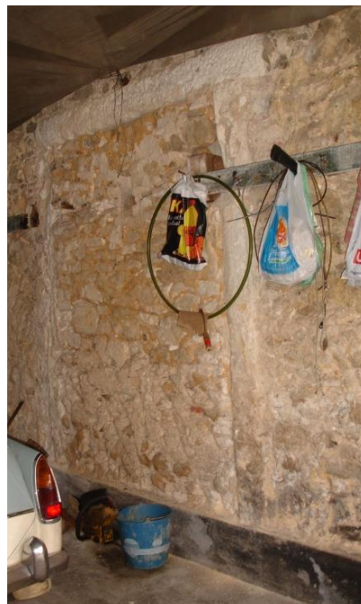
Fig. 43 - Pared exterior do refeitório com vestígios de fecho de um vão.
