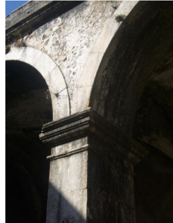
Fig. 59 - Calcário da região em colunas e arcos do claustro
