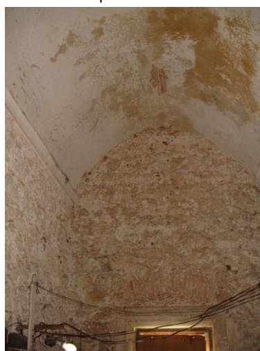
Fig. 71 - Abobada de volta perfeita no espaço situado no topo nordeste do piso térreo
