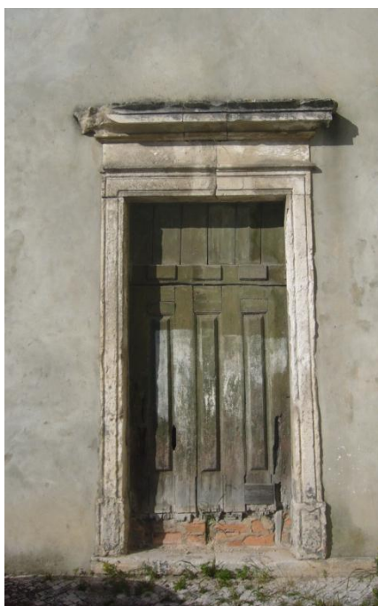
Fig. 17 - Porta da entrada principal do convento
