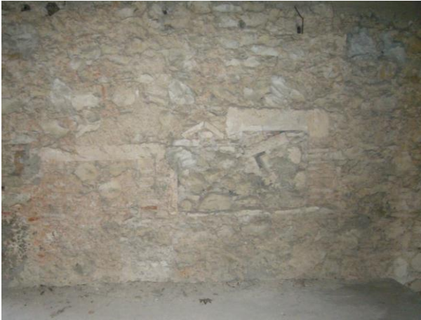
Fig. 58 - Parede exterior em alvenaria de pedra irregular
