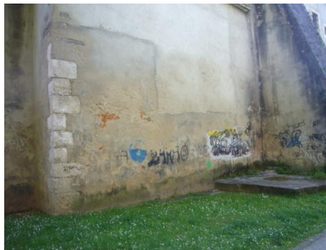
Fig. 73 - Humidade ascensional
