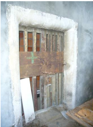
Fig. 60 - Pedra em cantaria de porta
