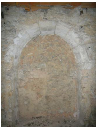
Fig. 52 - Capela – Arco em pedra na parede confinante com a igreja
