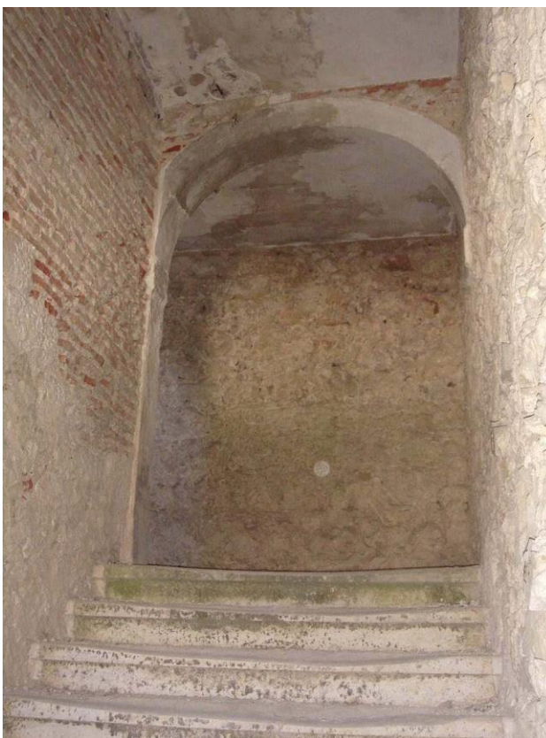
Fig. 49 - Escadas para acesso ao piso do dormitório.
