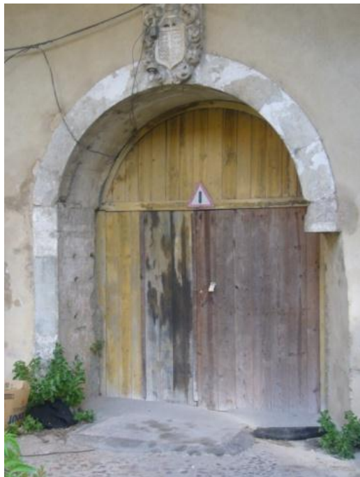
Fig. 39 – Portal de entrada na Sala do Capítulo. A ombreira à direita foi cortada para permitir o acesso de viaturas militares
