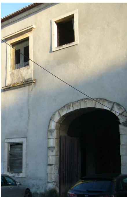
Fig. 20 - Portal no alçado poente com arco abatido e cantaria de pedra com alternância de espessuras - alargado pelos militares para acesso de viaturas .
