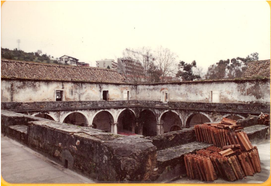
Fig. 11 - Terraço do piso superior sobre as galerias do claustro
