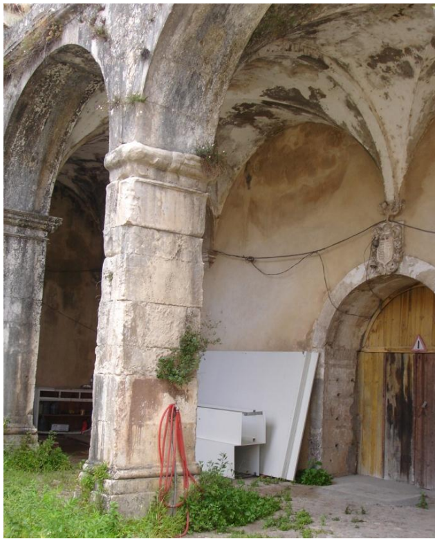
Fig. 31 – Galeria Nascente do claustro e portal da Sala do Capítulo
