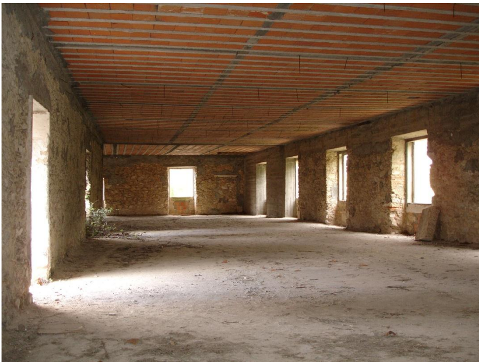
Fig. 51 - Dormitório – ala Nascente
