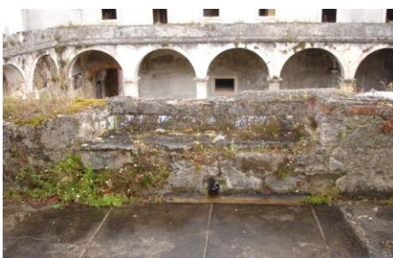
Fig. 36 - Muro na envolvente do terraço com bancos. Existem ainda alguns vestígios do revestimento com azulejos setecentistas.
