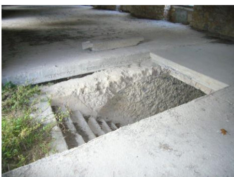
Fig. 56 - Escada de ligação entre o piso do dormitório e refeitório e cozinha no piso inferior.
