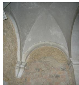
Fig. 69 - Arcos e mísulas da abobada da Sala do Capítulo
