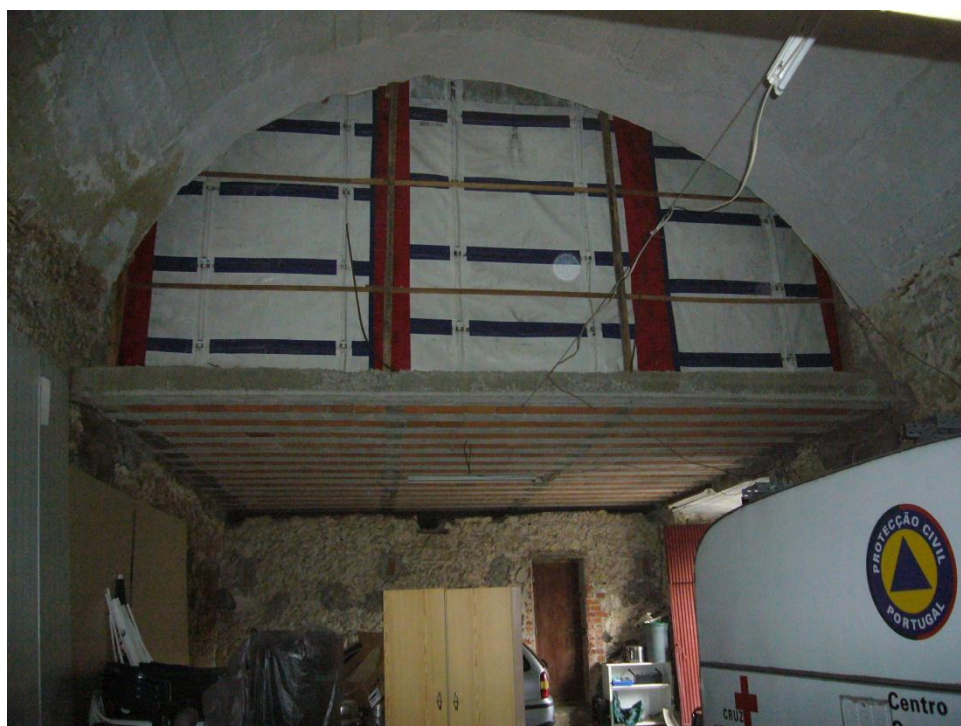
Fig. 44 - Armazém – antigo celeiro do convento
