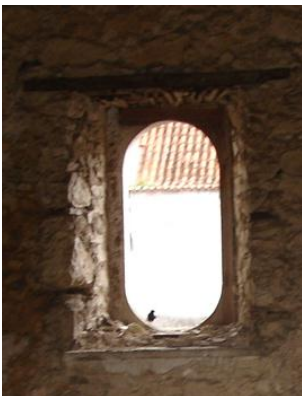
Fig. 63 - Madeira em lintéis de vãos exteriores
