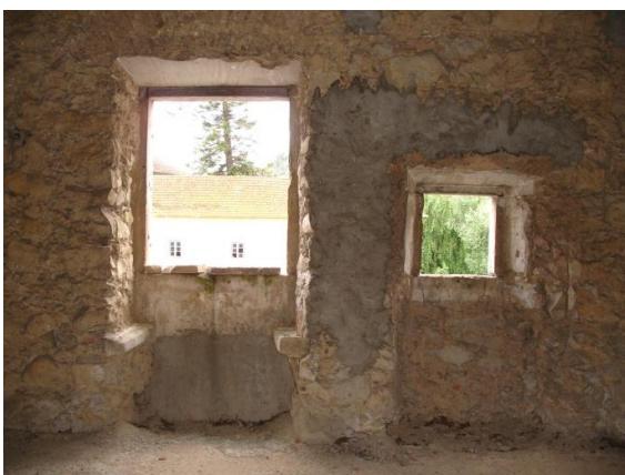
Fig. 54 - Janelas e postigos das celas dos frades
