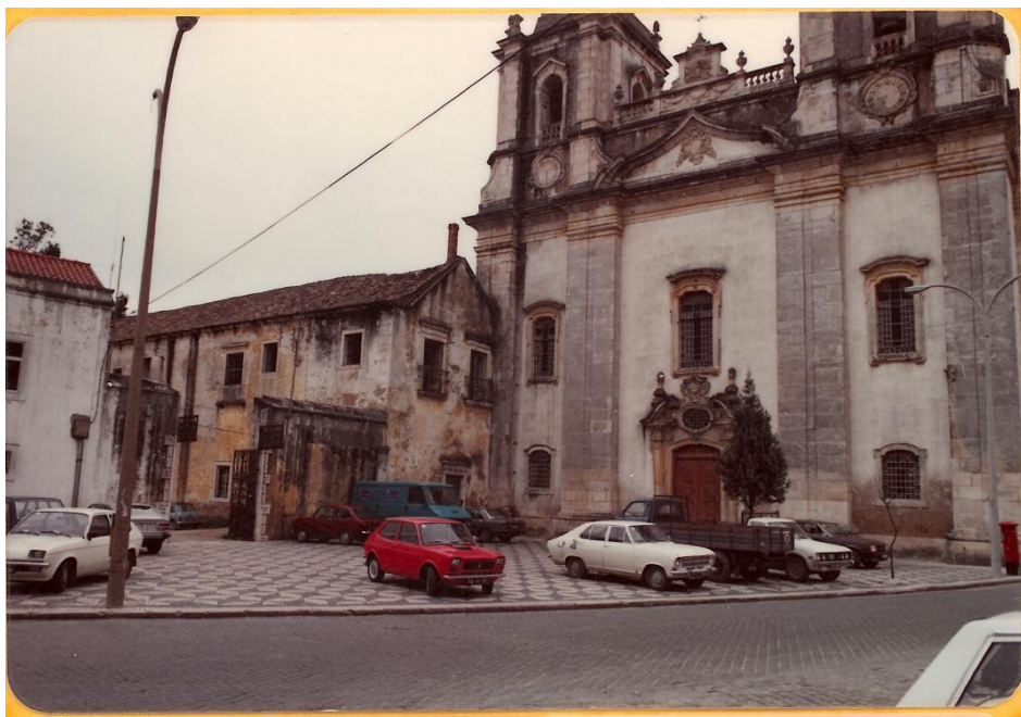
Fig. 5 - Fachada principal da Igreja e convento
