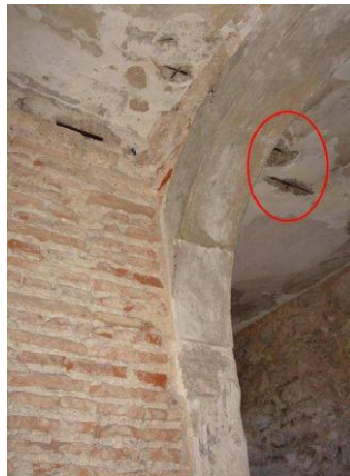
Fig. 61 - Tijolo em paredes
