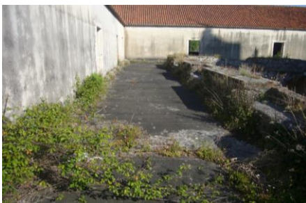
Fig. 35 - Colonização biológica do pavimento
