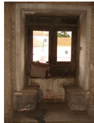
Fig. 65 - Madeira em caixilharias
