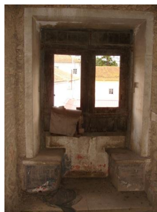
Fig. 55 - Vão de janela do dormitório
