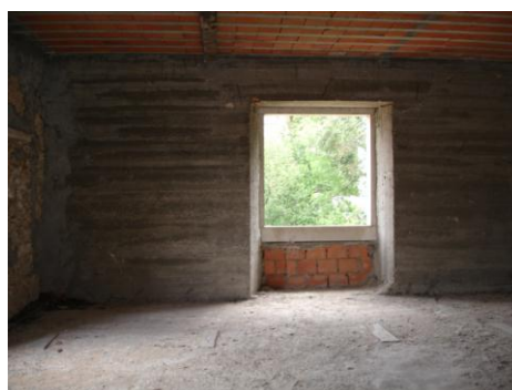
Fig. 57 - Parede exterior na ala Norte do dormitório
