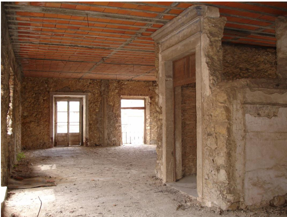
Fig. 50 - Espaço do Prior do convento e vão para acesso às escadas
