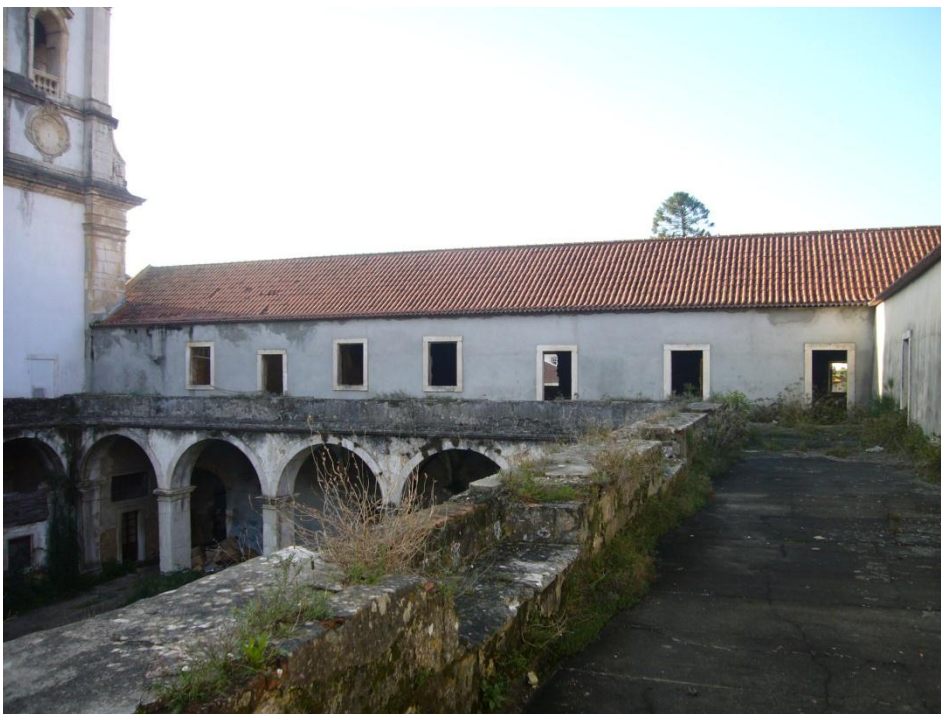
Fig. 34 – Terraço do claustro sobre galerias do piso inferior.
