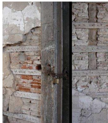
Fig. 64 - Madeira e tijolo em parede de tabique
