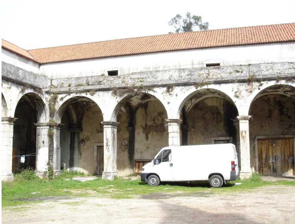
Fig. 28 – Galeria Nascente do claustro
