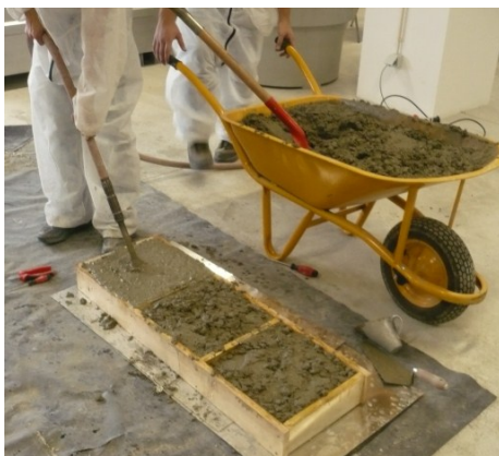
Figura 39: Colocação, vibração e nivelamento do betão.
