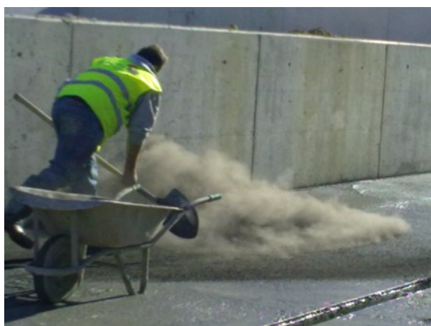
Figura 1: Aplicação do endurecedor.
