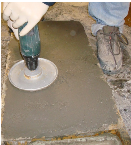
Figura 41: Processo de afagamento.
