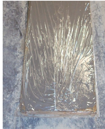
Figura 42: Colocação da película aderente sobre a lajeta.
