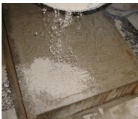
Figura 40: Colocação do endurecedor.
