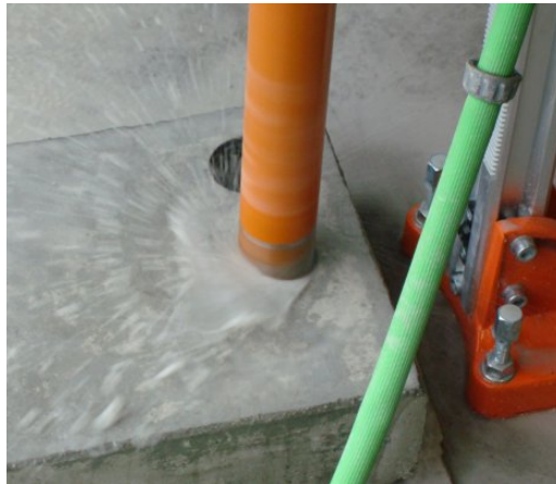
Figura 29: Caroteamento da superfície da lajeta.
