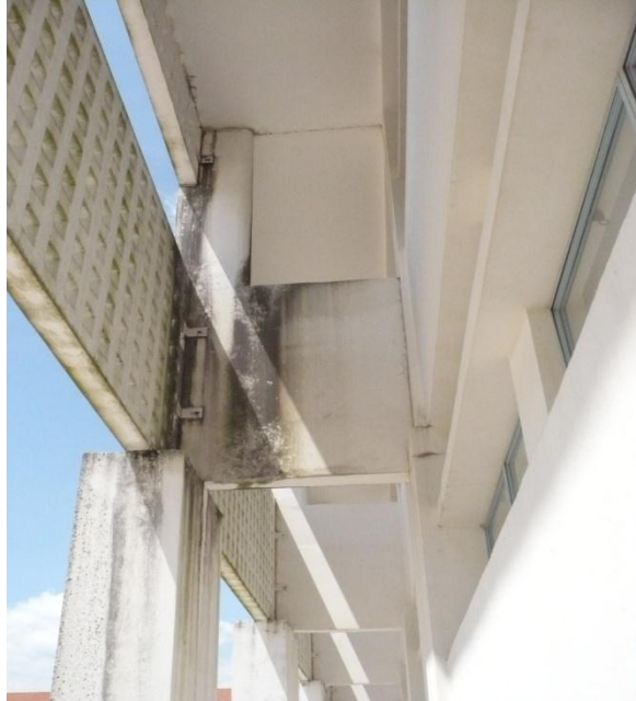
Figura 9- Viga de ligação do paramento exterior
