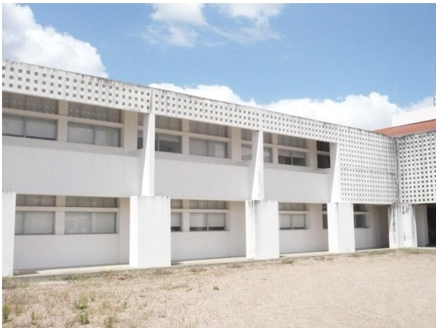
Fotografia 4- Fachada orientada a Sul
