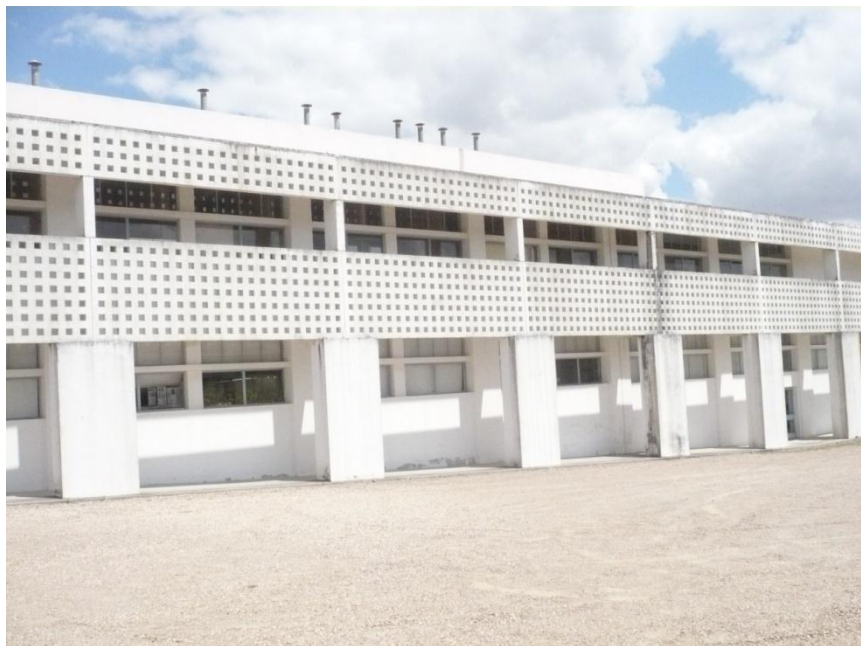
Fotografia 2- Fachada orientada a Oeste
