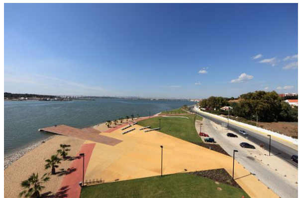
Figuras 119 e 120 – Em cima, maqueta da proposta de requalificação, e em baixo, a execução da proposta.
