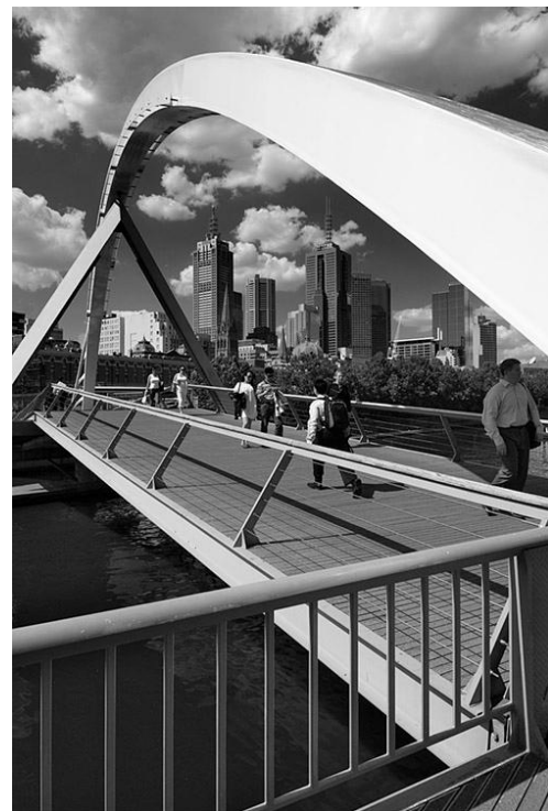
Figura 52- Ponte pedonal que estabelece a ligação entre o centro de Melbourne e a zona sul. Fonte: http://www.pbase.com/image/91054363
