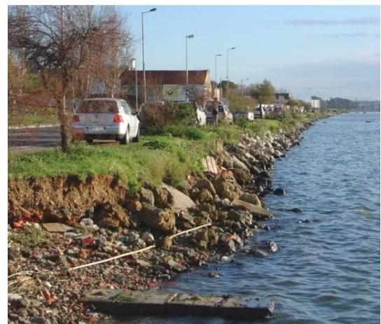
Figura 127 – Espaço anterior à intervenção. Fonte: Divisão de Projeto (DEC), Câmara Municipal do Seixal
