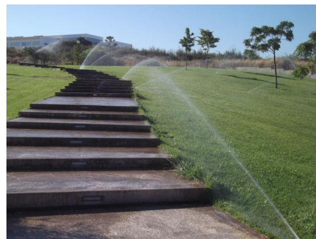
Figuras 132 e 133 – Ineficácia no sistema de rega; Em cima, troço 2 (Amora) e em baixo, troço 7 (Quinta dos Franceses). Fonte: Autora
