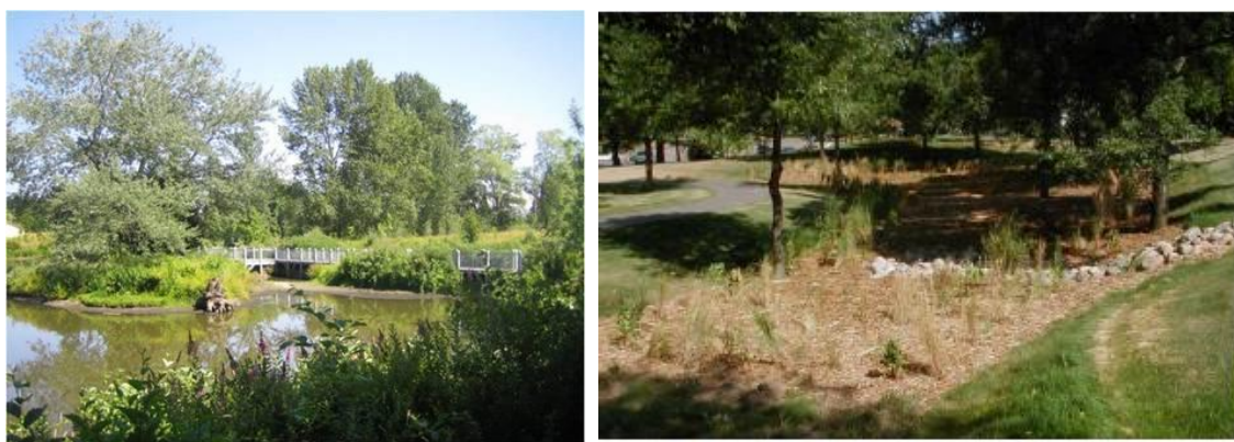
Figuras 35 e 36- À esquerda, bacia de retenção Meadowbrook, Seattle e à direita bacia de infiltração. Fontes: http://www.arq.ufsc.br/arq5661/trabalhos_2007-1/drenagem e JACOME (2010). A água e a sustentabilidade em espaços verdes
