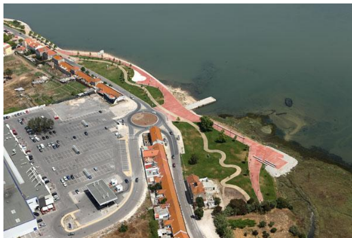
Figura 95 – Vista aérea da intervenção.
