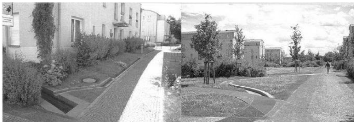
Figuras 39 e 40 - Nesta área residencial, a água proveniente da chuva é retida nos telhados e transportada, através de canais, para um reservatório subterrâneo, sendo reaproveitada para a manutenção dos espaços ajardinados. Urbanização Marzahn, Berlim. Fonte: JACOME (2010). A água e a sustentabilidade em espaços verde
