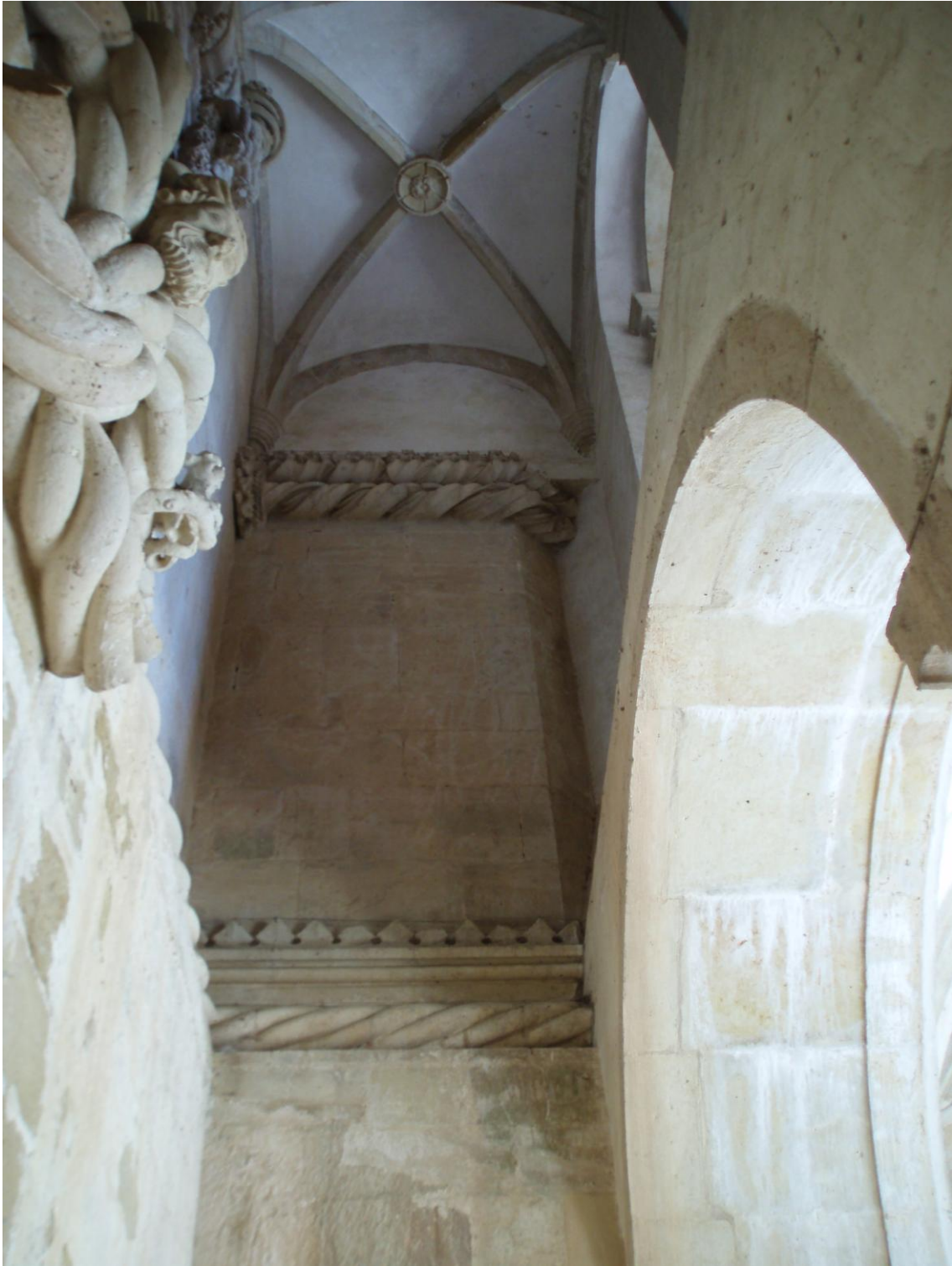
Fig. 303 – Convento de Cristo. Claustro Principal. Espaço intercalar entre o Claustro e o alçado Sul da Igreja manuelina, vista para o sistema de abóbadas castilhanas. 2008. Fotografia de Jorge Custódio. Inédita. Vol. I, tomo 2, p. 1324.
