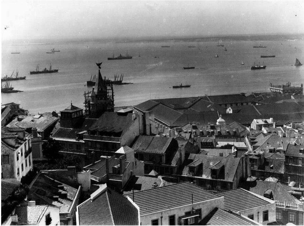
Fig. 109 – Sé Catedral de Lisboa. Construção do corchêu da torre norte da igreja. 1908-1909. DGEMN. Foto n.º 514590. Vol. I, tomo 1, p. 522.
