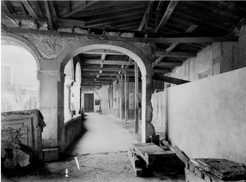
Fig. 281 – Sé de Lisboa. Claustro. Obras de remoção e limpeza da galeria superior. Fotografia. Cerca de 1920. Arquivo Fotográfico da ex-DGEMN (actual IHRU), foto 516298. Vol. I, tomo 2, pp. 1304 e 1305.
