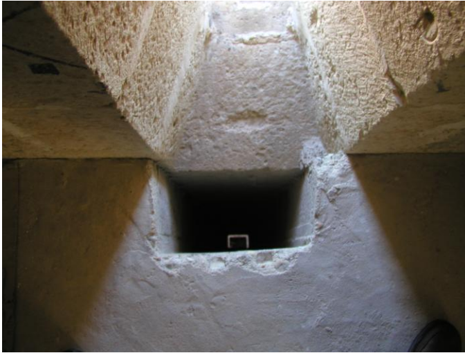
Fig. 270 – Fosso vertical para a colocação dos pesos do relógio da Torre. 2007. Fotografia Jorge Custódio. Inédita. Vol. I, tomo 2, p. 1283.
