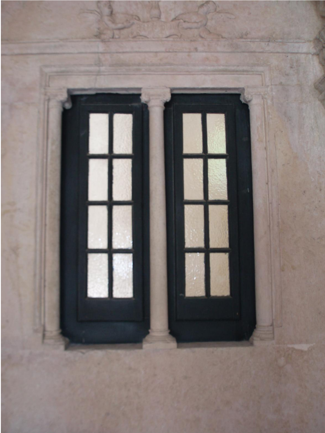
Fig. 295 – Janela mainelada da nova entrada do vestíbulo do Capítulo dos freires de clausura. 2008. Fotografia Jorge Custódio. Inédita. Vol. I, tomo 2, p. 1320.
