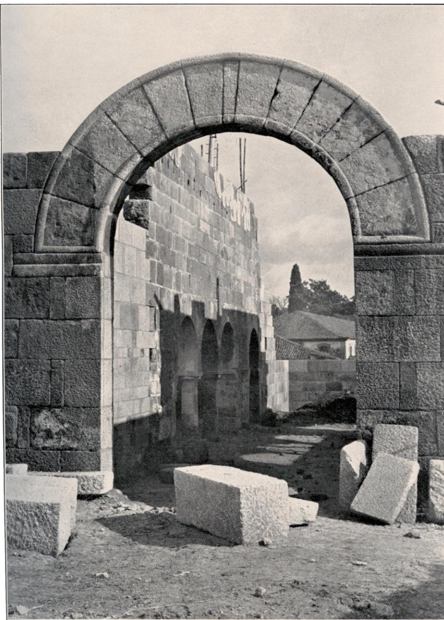
Est. 13 — Reconstrução da frontaria do «nartex»
