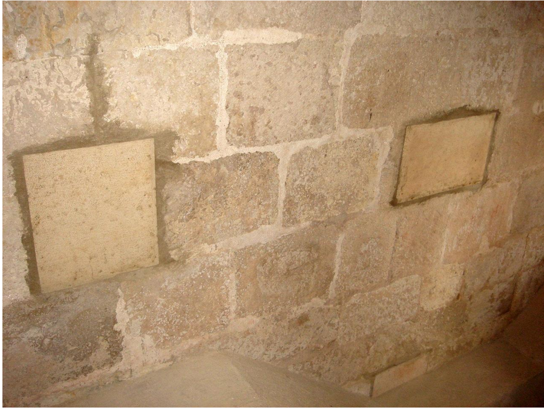
Fig. 274 – Torre do Relógio. Interior. Alçado norte. Revestimento com silhares de pedra de dois lintéis de betão para reforço do campanário. 2007. Fotografia Jorge Custódio/Rui Ferreira. Inédita. Vol. I, tomo 2, p. 1284.
