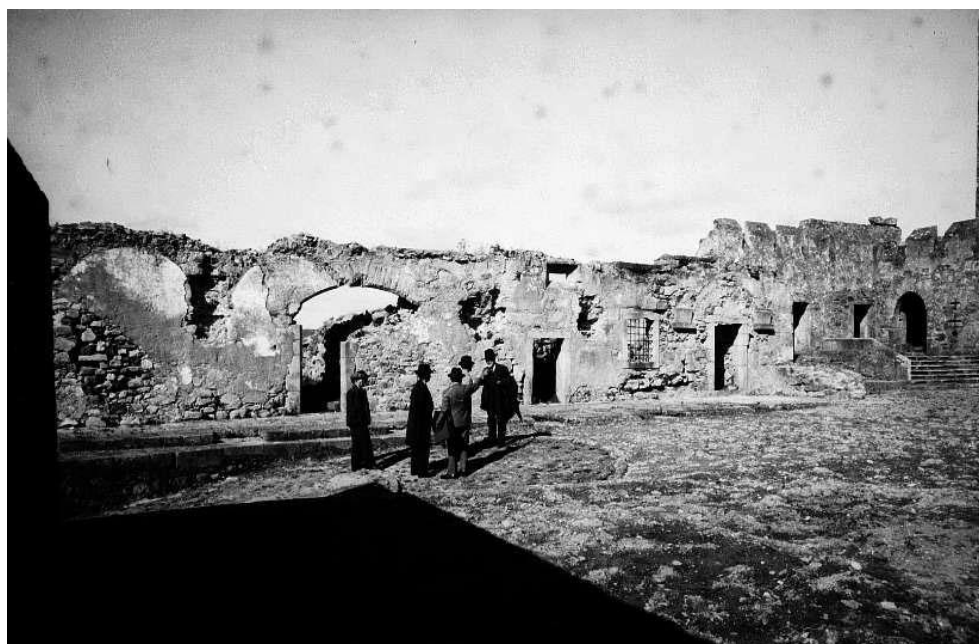
Fig. 162 – Castelo de Vila da Feira. Depois da destruição do Paço dos Condes da Feira no interior do recinto do Castelo. Fotografia. Cerca de 1935. Arquivo fotográfico da Ex-DGEMN (actual IHRU). Foto n.º 071915. Vol. I, tomo 2, p. 802.
