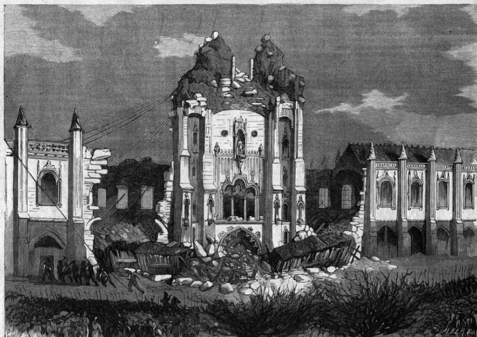
DESMORONAMENTO DO CORPO CENTRAL DO NOVO EDIFÍCIO DA CASA PIA, EM BELEM, OCCORRIDO NO DIA 18 DE DEZEMBRO DE 1878 (segundo um esboço do natural de Domingos Cazellas)
