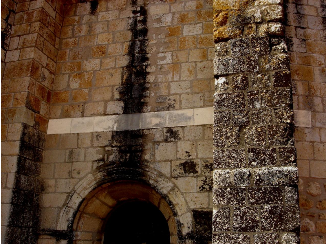
Fig. 272 – Charola. Alçado principal. Lintel de reforço superior da janela românica. 2007. Fotografia Jorge Custódio/Rui Ferreira. Realçada por processo digital. Inédita. Vol. I, tomo 2, p. 1284.
