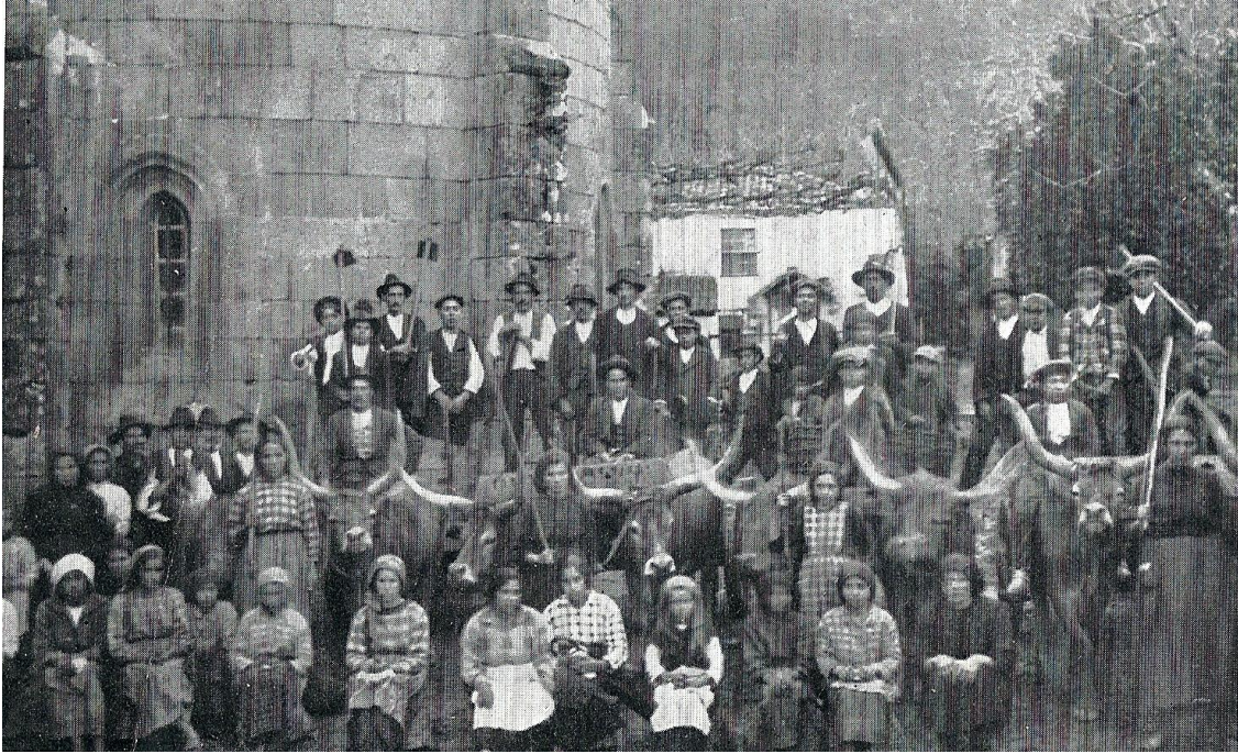
Fig. 245 – Grupo de populares integrados nas obras de restauro da igreja de Cête . Fotografia de Marques de Abreu, filho. In “Monumentos Nacionais. Uma visita ao Mosteiro de Cête” de [Marques de Abreu]. In Ilustração Moderna , 4.º Ano, n.º 38, Porto, Dezembro de 1929, p. 480. Vol. I, tomo 2, p. 1145 e 1222.
