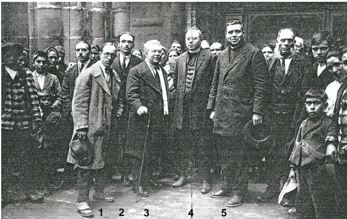
Fig. 243 – Início dos trabalhos de restauração da Igreja de Paço de Sousa , cliché de Pedro Vitorino. In “A Igreja de Paço de Sousa”, de Pedro Vitorino, Ilustração Moderna , n.º 12, Abril de 1927, p. 287. Vol. I, tomo 2, p. 1145.
