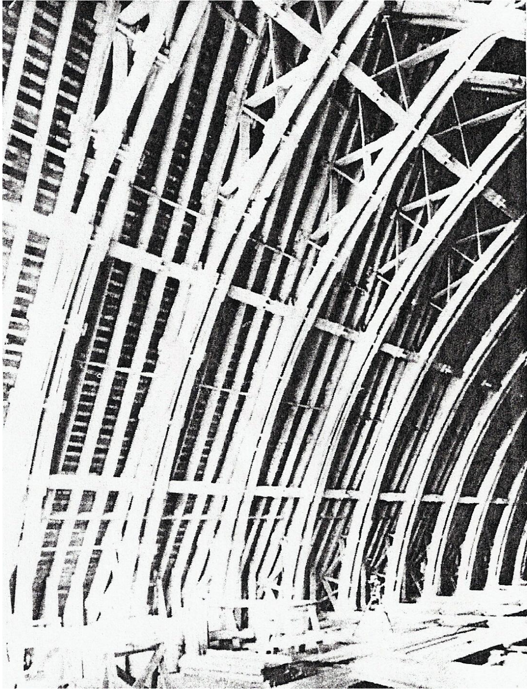
Fig. 241 – Restauro da cobertura da Catedral de Reims . Fotografia da Coleção de Yves-Marie Froidevaux, cerca de 1922. In FROIDEVAUX, Yves-Marie, Techniques de l'Architecture Ancienne : Construction et Restauration , 2.ème edition, Paris: Pierre Mardaga Éditeur, 1985, p. 101. Vol. I, tomo 2, pp. 1146, 1156 e 1281.
