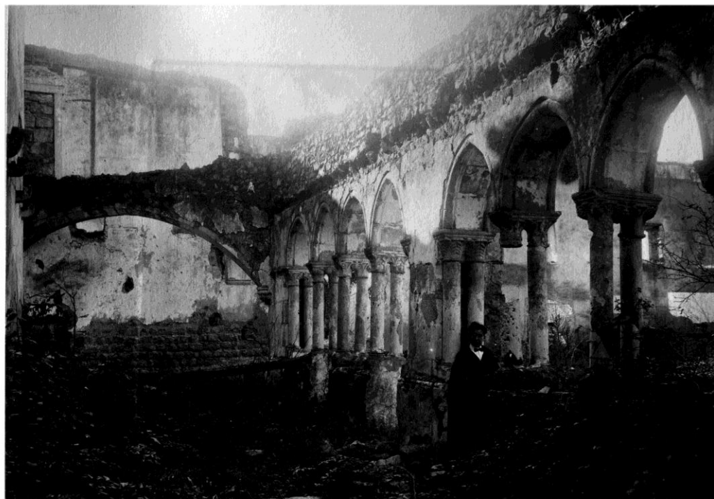
Fig. 35 – Almoester. Vista do Claustro [com sinais evidentes de abandono e derrocada das galerias norte e poente]. Fotografia. Inícios do século XX. Fotógrafo desconhecido. Álbum fotográfico , n.º 5368, ANBA: MM – 6-4, foto n.º 12. Inédita. Vol. I, tomo 1, p. 124.
