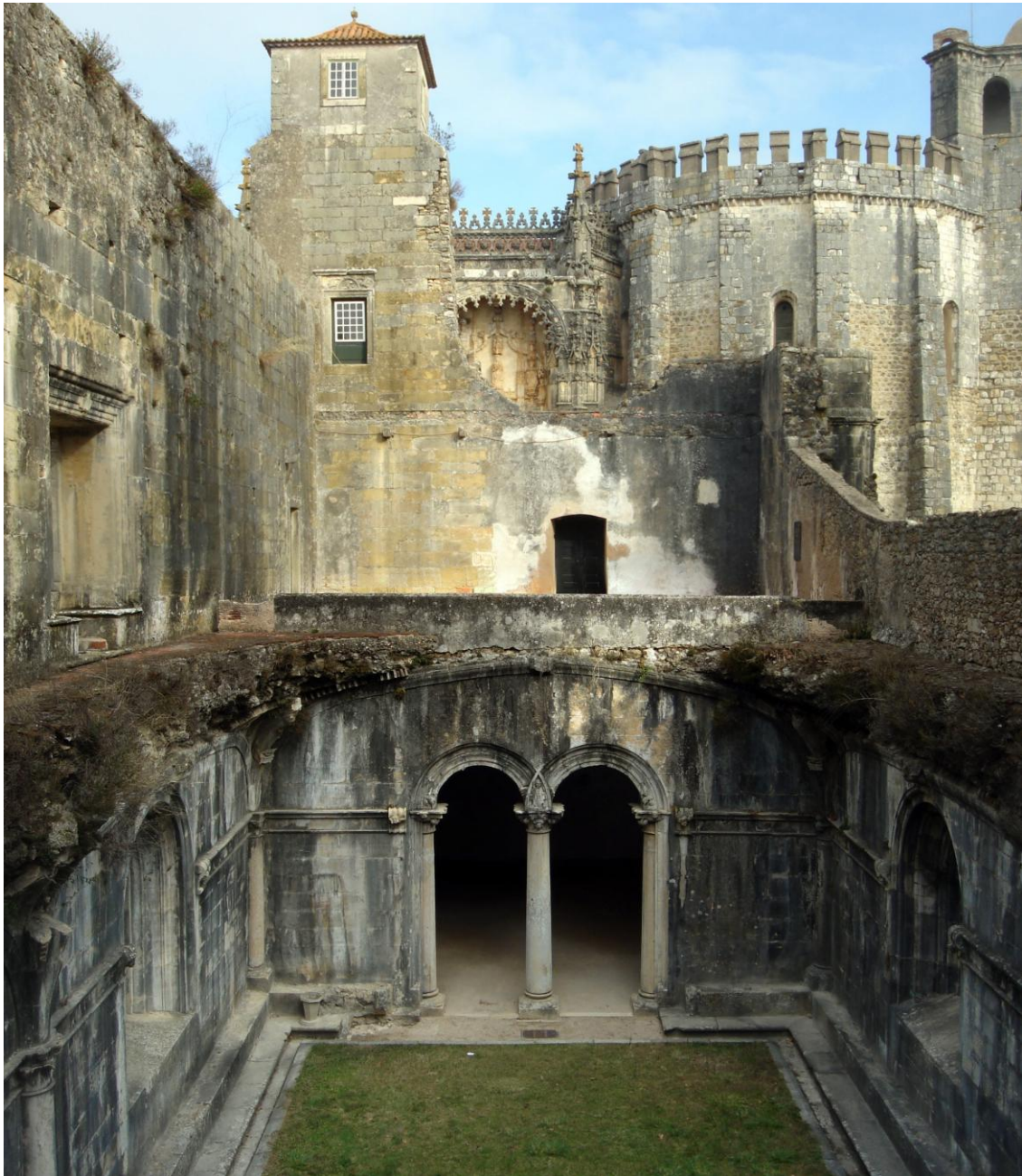
Fig. 289 – Casa do Capítulo Incompleta. Vista Sul-Norte. 2008. Fotografia Rui Ferreira. Inédita. Vol. I, tomo 2, p. 1316.
