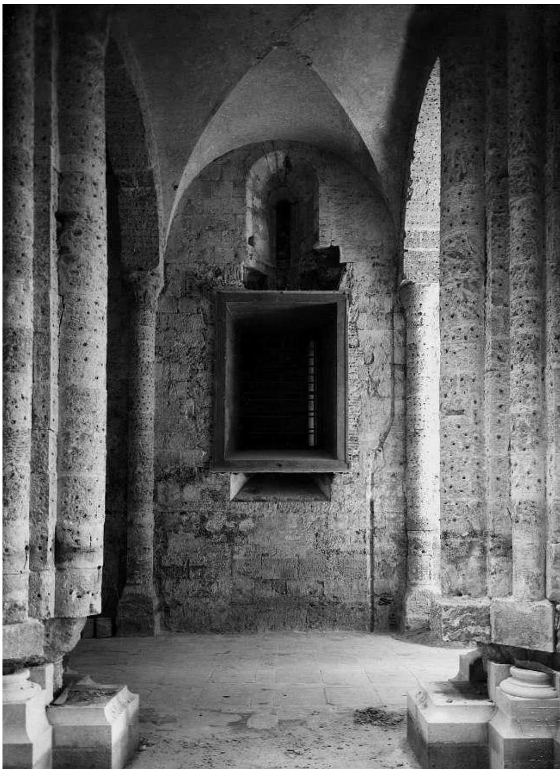
Fig. 287 – Sé de Lisboa. Colunas românicas após a remoção do reboco e em fase de reconstrução e restauro das primitivas bases a partir de modelos originais. Fotografia. Cerca de 1940. Arquivo Fotográfico da ex-DGEMN (actual IHRU), foto 516080. Vol. I, tomo 2, pp. 1308 e 1309.
