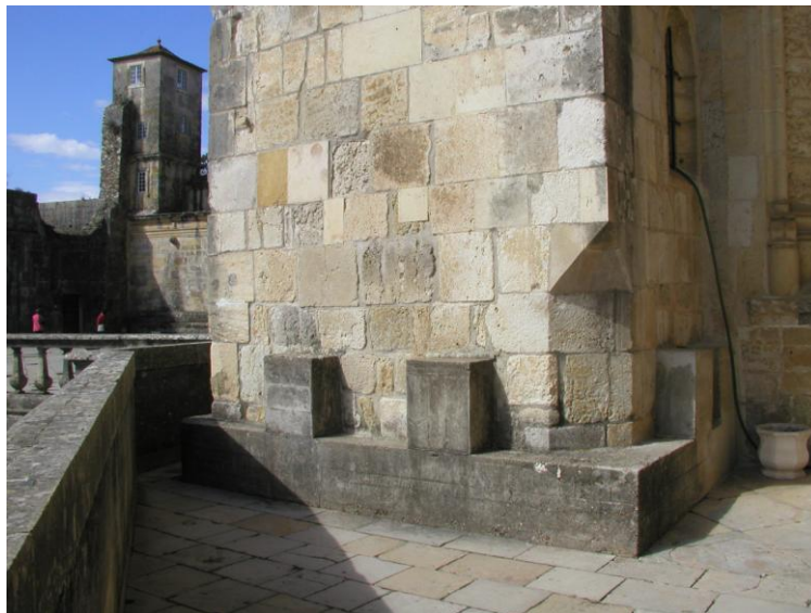
Fig. 265 – Torre do Relógio da Charola do Convento de Cristo. Intervenção de reforço da torre com lajes e lintéis de betão armado. 2007. Fotografia Jorge Custódio/Rui Ferreira. Inédita. Vol. I, tomo 2, p. 1282.
