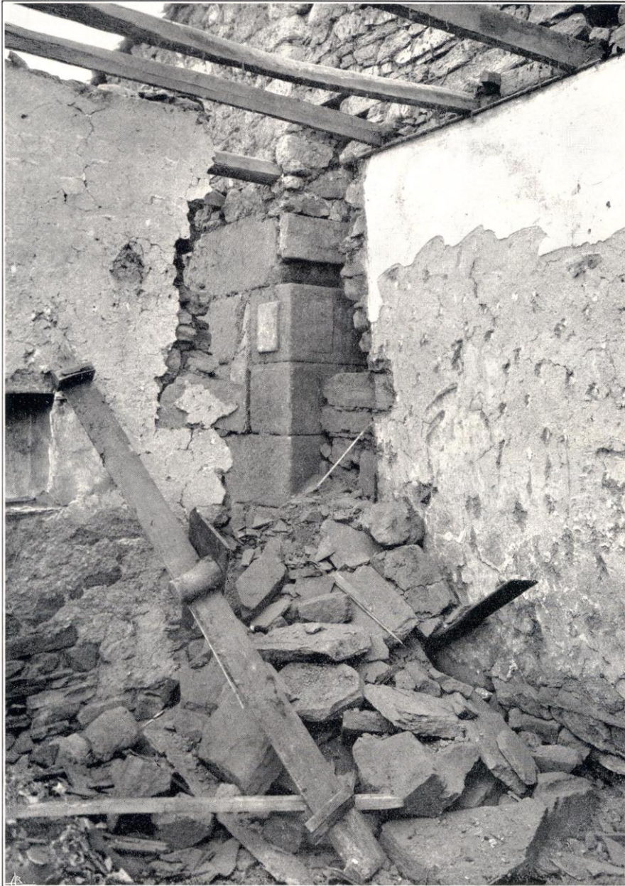
Est. 24—Sondagens no cunhal da nave do noroeste
