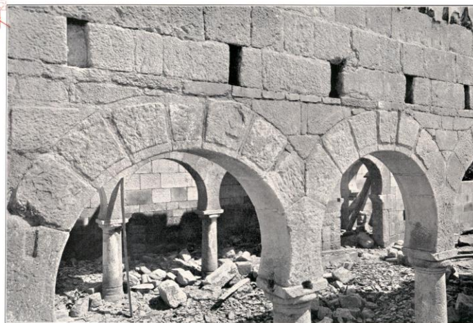
Est. 53 — Aduelas rusticadas dos arcos divisórios das naves e as cavidades sobranceiras dos madeiramentos, primitivos, em a nave do sul
