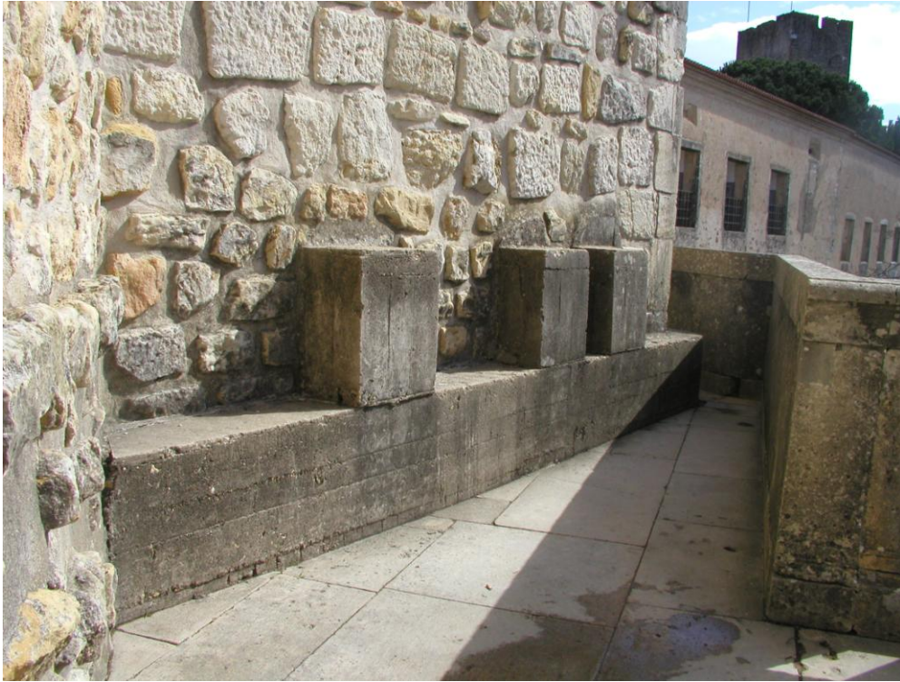
Fig. 266 – Torre do Relógio da Charola do Convento de Cristo. Aspecto sul da obra de betão armado na base da torre. 2007. Fotografia de Jorge Custódio. Inédita. Vol. I, tomo 2, p. 1282.
