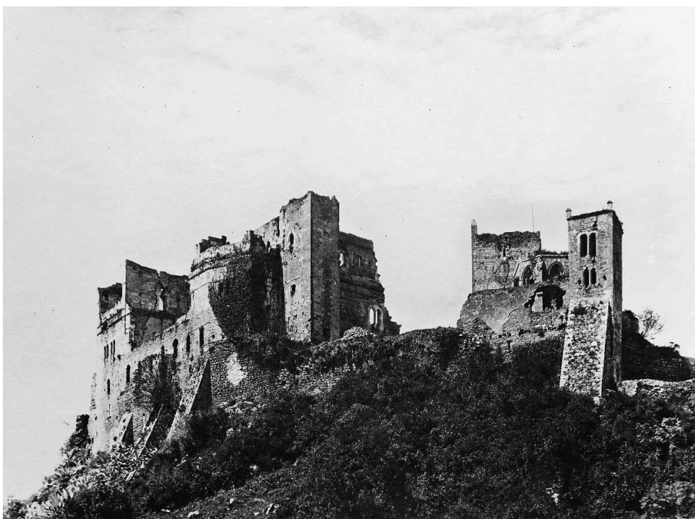
Fig. 164 – Castelo de Leiria . Vista geral das ruínas da alcáçova e da área palatina, antes das obras de consolidação e restauro. Fotografia. Inícios do século XX. Arquivo fotográfico da Ex-DGEMN (actual IHRU). Foto n.º 076785. Vol. I, tomo 2, p. 804.
