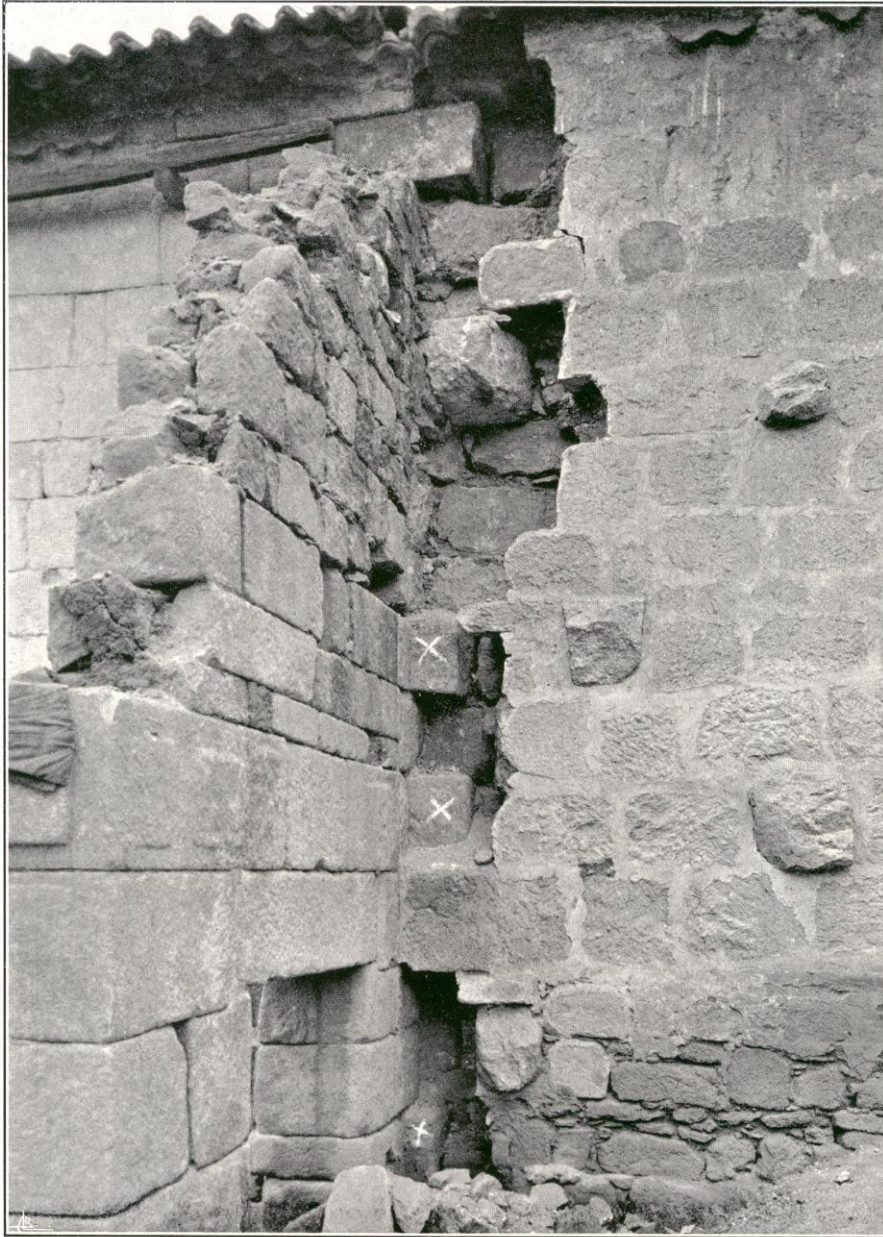
Est. 26—Ângulo noroeste da fachada principal e dentação primitiva (X) do «nartex»
