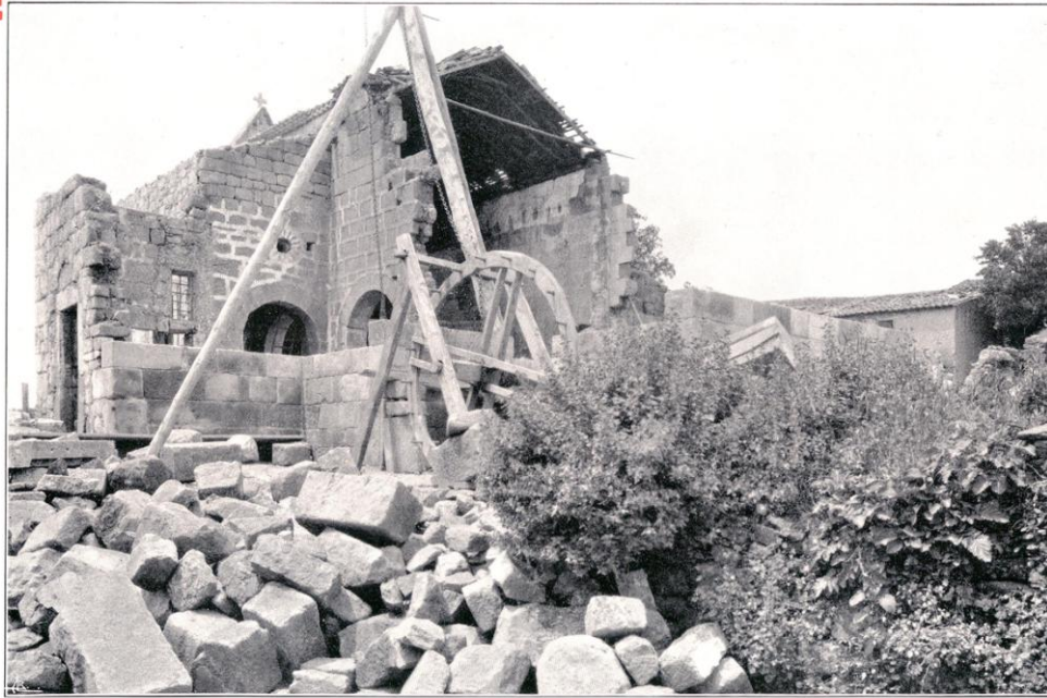
Est. 40 — Ângulo reentrante, formado pelo extremo sul do transepto, e o absidíolo do mesmo lado
