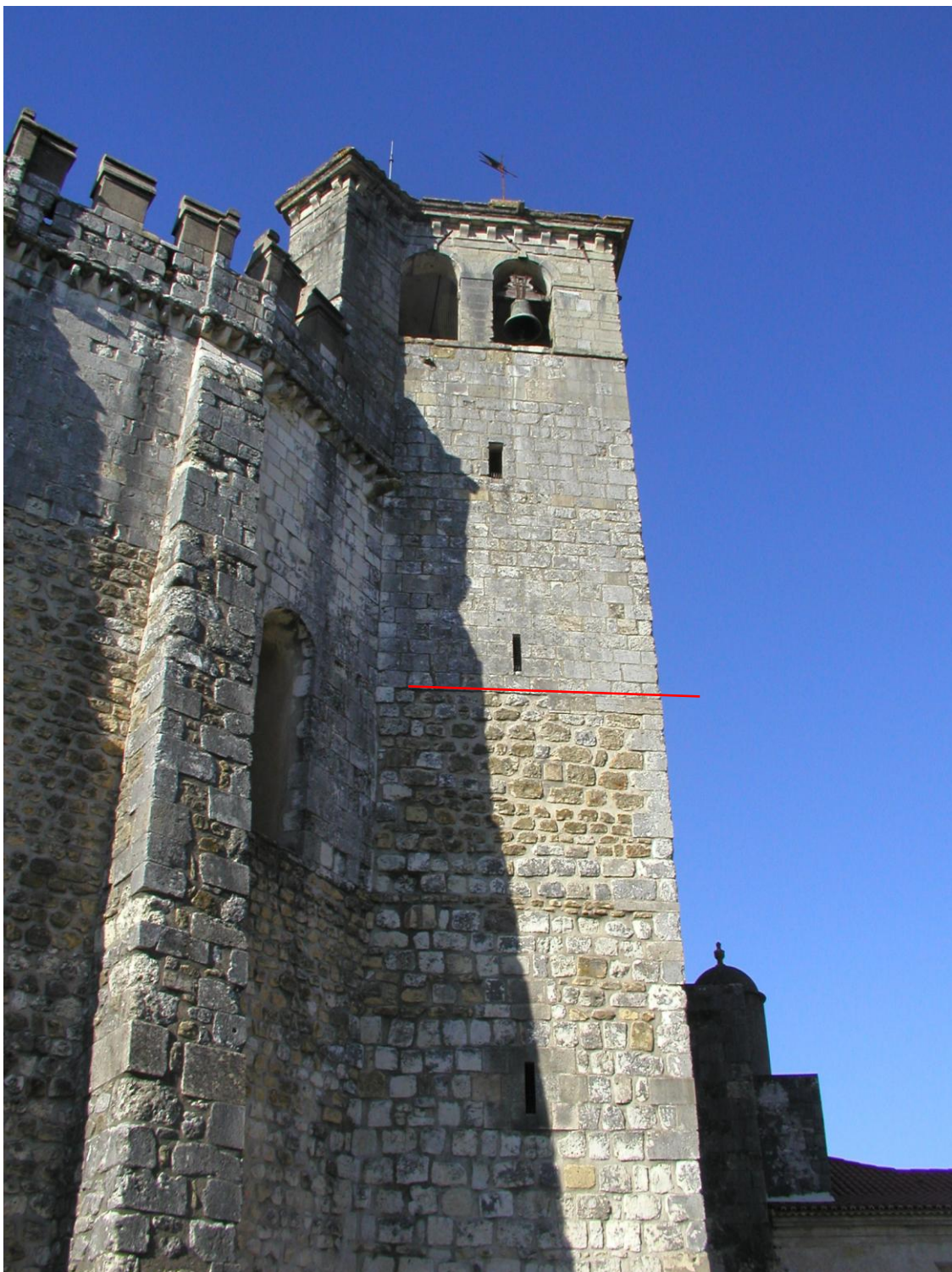
Fig. 268 – Torre do Relógio da Charola do Convento de Cristo. Estereotomia do aparelho silhar do alçado sul. 2007. Fotografia Jorge Custódio. Inédita. Vol. I, tomo 2, p. 1282.
