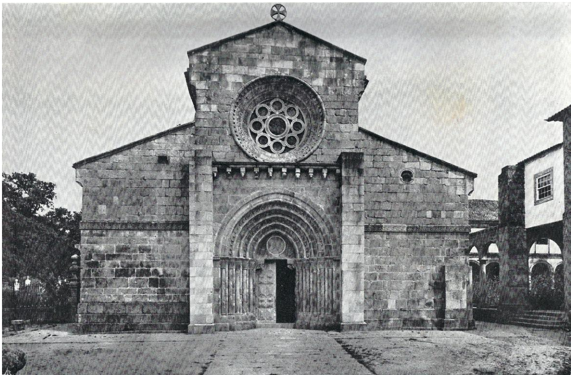
Fig. 224 A – Igreja de Paço de Souza (Concelho de Penafiel), depois do restauro de reintegração / restituição integral. In Igreja de Paço de Souza , Boletim da DGEMN, Monumentos 17, Lisboa: MOPC, Setembro de 1939, Vol. I, tomo 2, p. 1164 e 1222.
