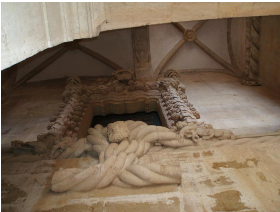
Fig. 302 – Convento de Cristo. Claustro Principal. Espaço intercalar entre a quadra norte do claustro de Diogo de Torralva e o alçado sul da Igreja manuelina. 2008. Jorge Custódio. Inédita. Vol. I, tomo 2, p. 1324.
