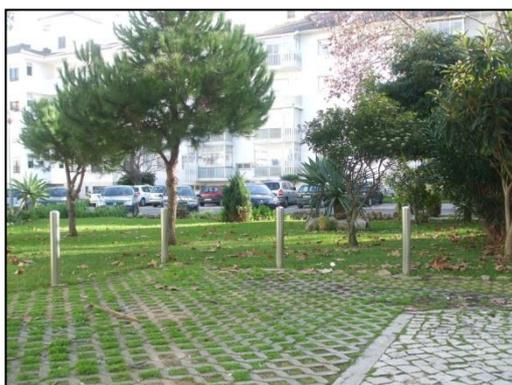
**Figura 24 – Pavimento permeável, para estacionamento, em Carcavelos (Praceta Gil Eanes). Foto do autor**
