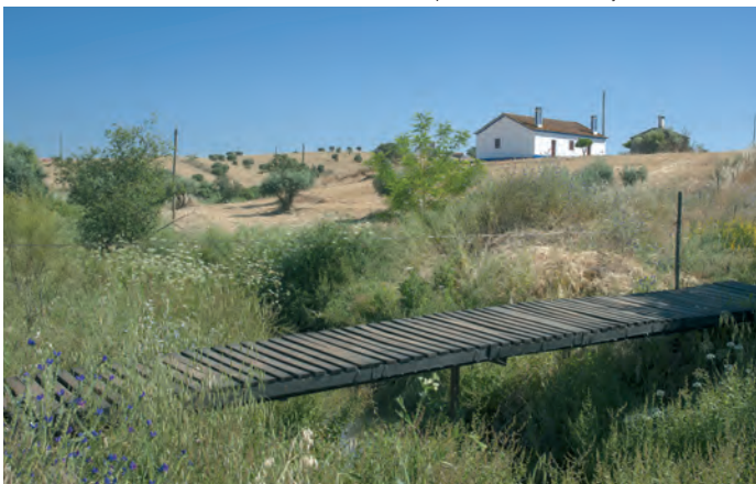
Ponte pedonal entre o Monte da Graça e o Monte da Cruz
